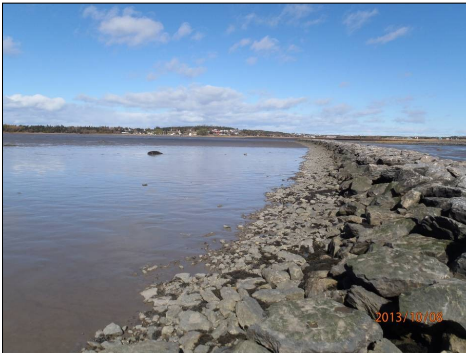
Photo 7 : Vue du côté extérieur du brise-lames, depuis l'extrémité sud-ouest en direction nord-est, 8 octobre 2013
