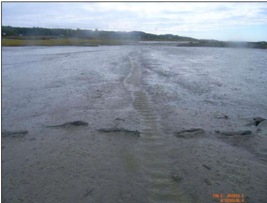
Photo 19 : Vue du chenal apparent à marée basse à l'intérieur de la digue en enrochement, 19 septembre 2012
