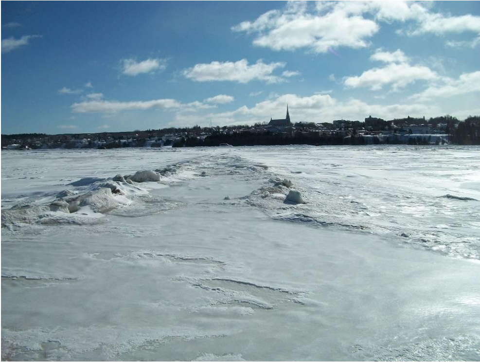
Photo 1 : Vue de la digue transversale à marée basse, 17 mars 2014
