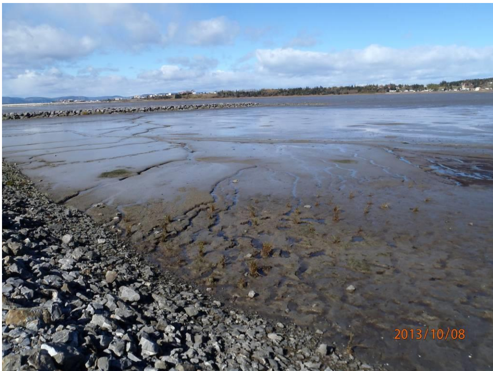
Photo 14 : Vue générale, à partir de la rive, de la section nord-est de la zone protégée, 8 octobre 2013
