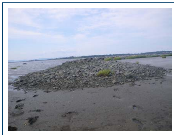
PHOTO 18 : Vue de l'ailette sud en direction du brise-lames, 24 août 2016
