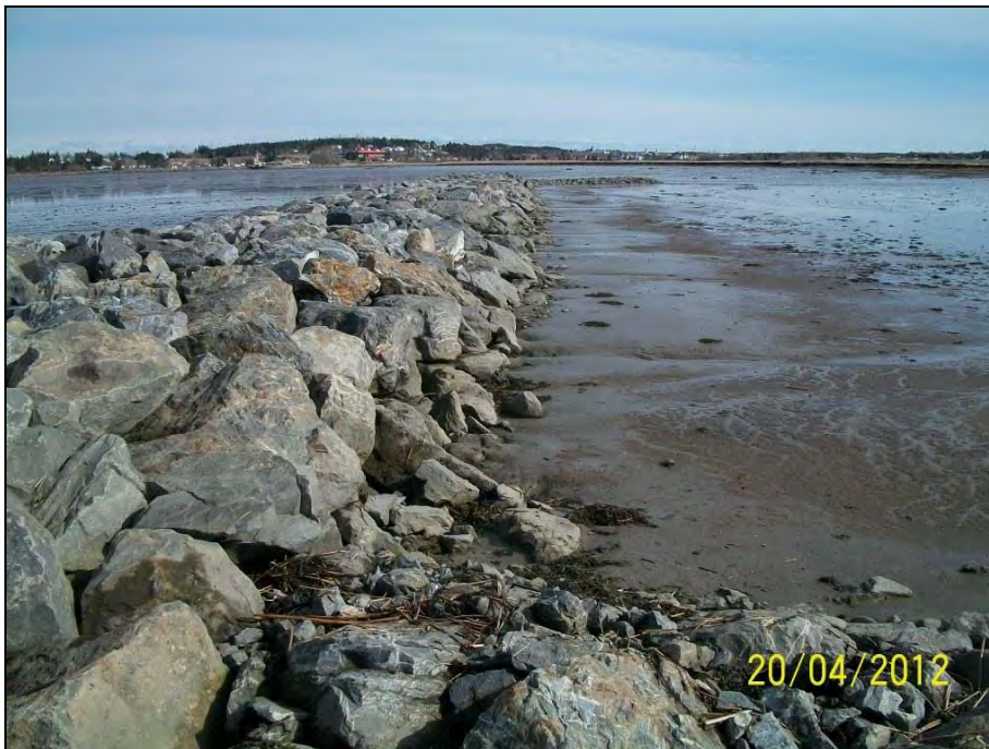
Photo 3 : Vue vers le nord-est et l'intérieur de la digue parallèle à la rive, 20 avril 2012
