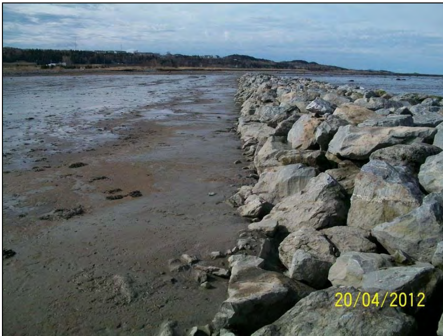
Photo 5 : Vue vers le sud-ouest et l'intérieur de la digue parallèle à la rive, 20 avril 2012
