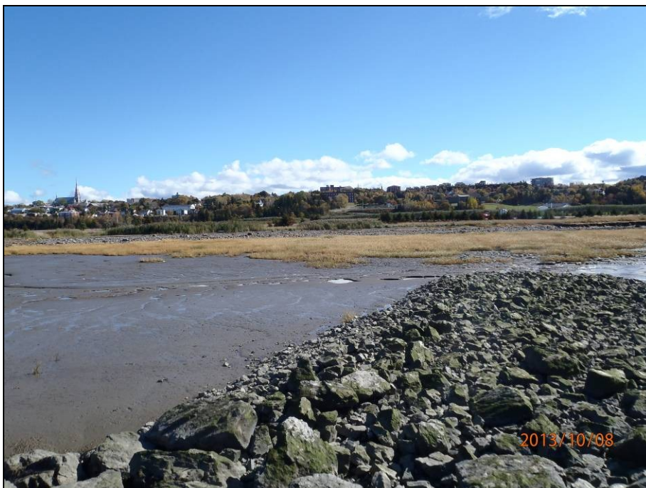
Photo 8 : Vue de l'ailette de l'extrémité sud-ouest du brise-lames, 8 octobre 2013
