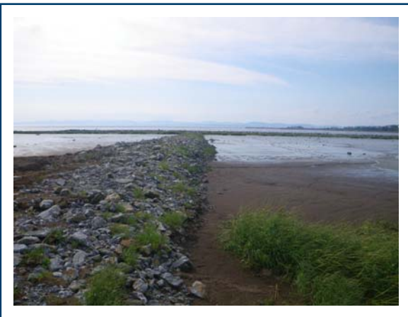
PHOTO 11 : Vue générale de la structure à marée basse, 24 août 2016
