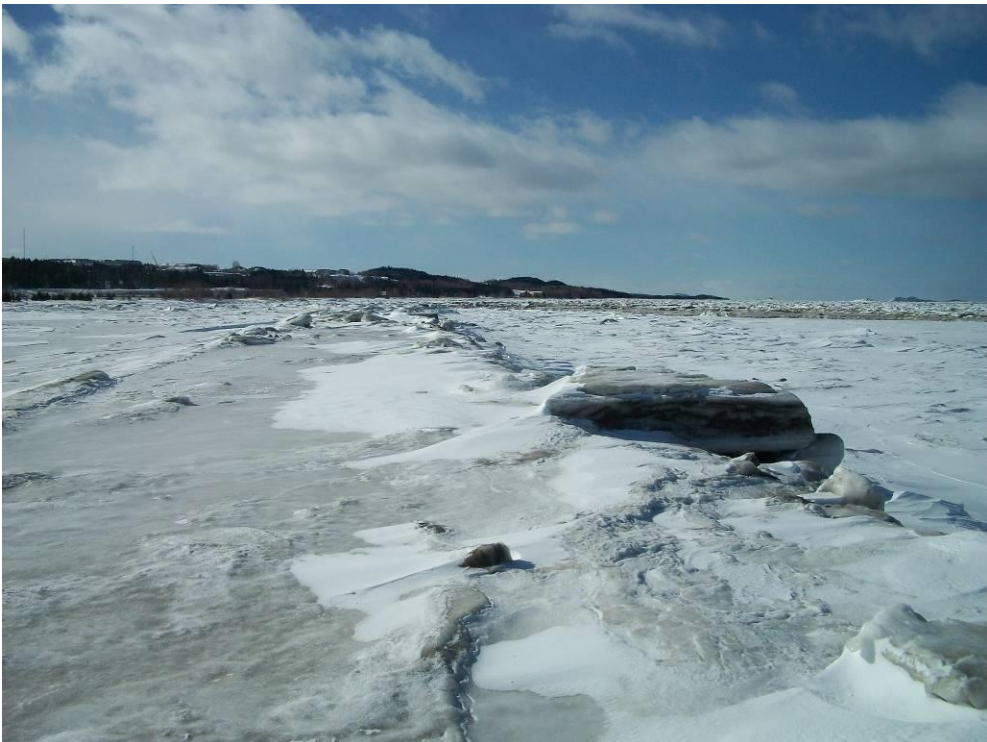
Photo 2 : Vue de la portion sud-ouest du brise-lames à marée basse, 17 mars 2014
