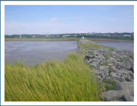
PHOTO 7 : Vue de la digue transversale à marée basse, 24 août 2016
