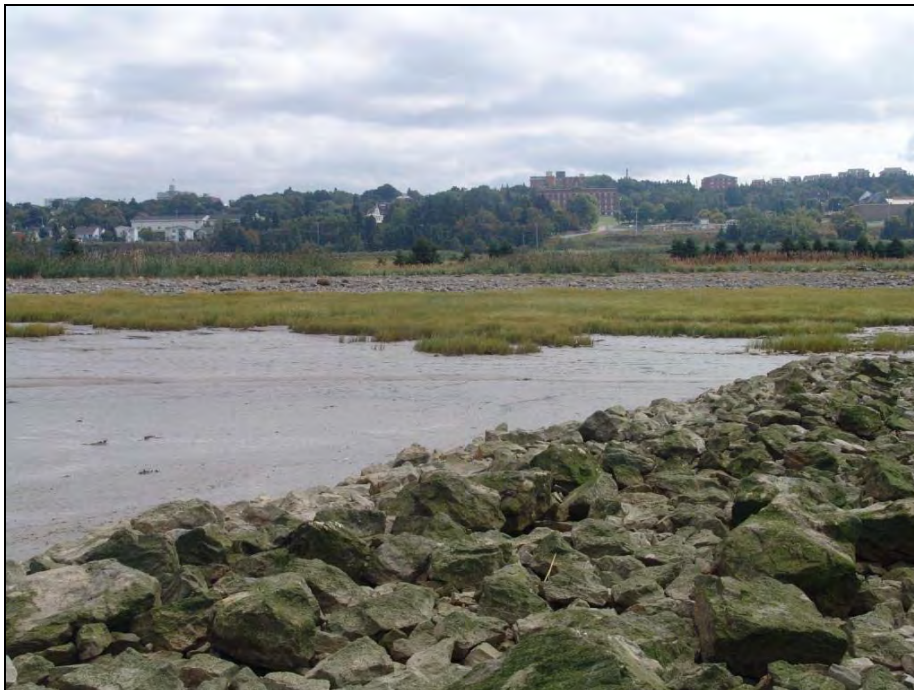
Photo C Reprise naturelle du marais à l'intérieur de la digue en enrochement, secteur intérieur Sud-Ouest, 5 septembre 2012
