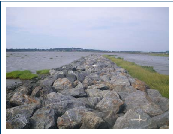
PHOTO 9 : Vue de la portion nord-est du brise-lames à marée basse, 24 août 2016
