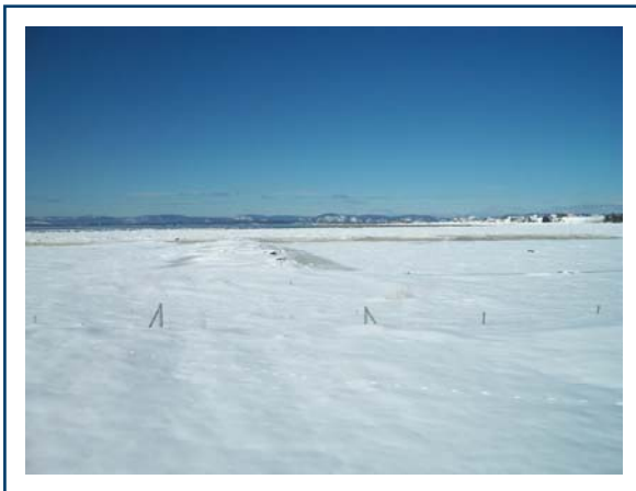
PHOTO 5 : Vue générale de la structure à marée basse, 11 mars 2016
