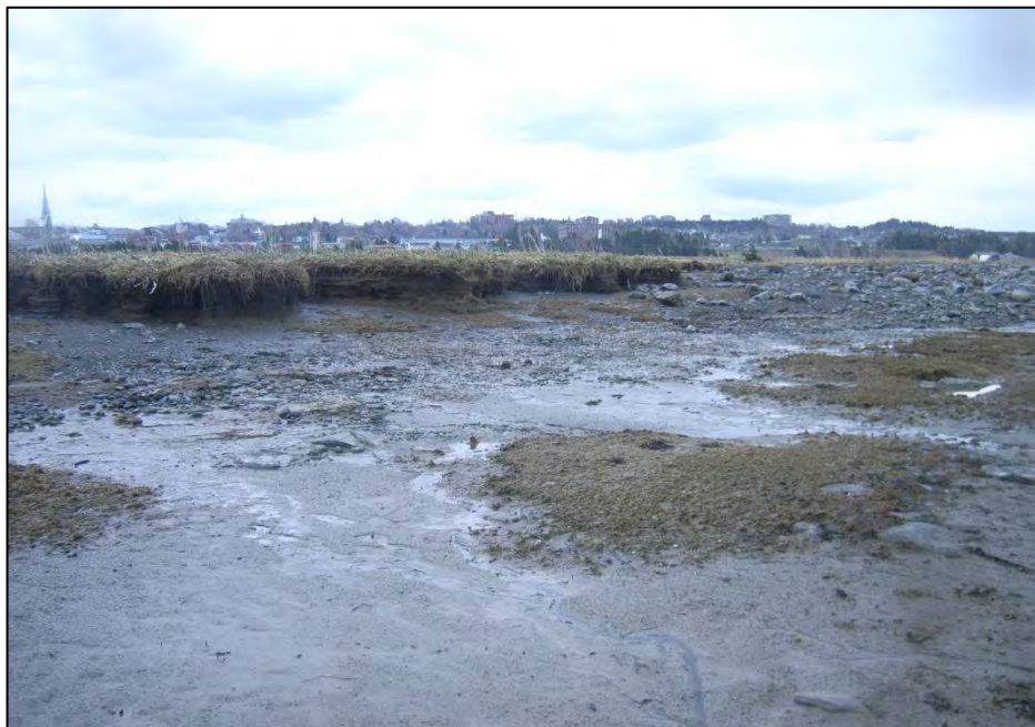
Photo D Érosion du talus, 8 mai 2012.
