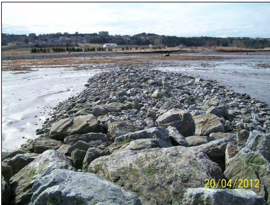
Photo 8 : Vue de l'ailette de l'extrémité sud-ouest de la digue parallèle à la rive, 20 avril 2012
