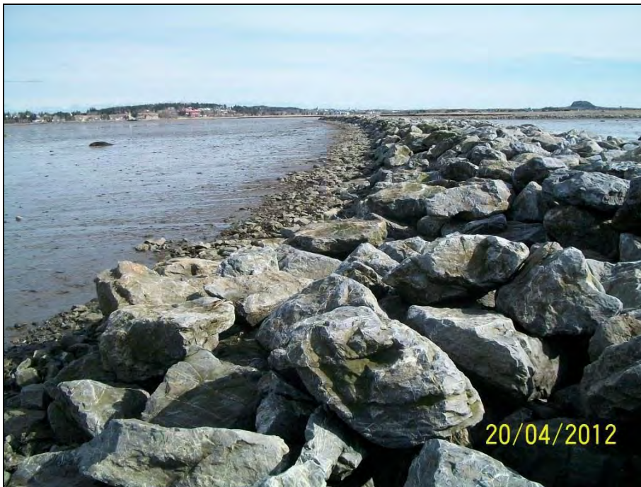
Photo 7 : Vue du côté extérieur de la digue parallèle à la rive, depuis l'extrémité sud-ouest en direction nord-est, 20 avril 2012
