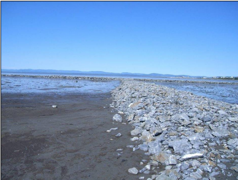
Photo 2 : Vue du côté sud-ouest de la digue transversale, 28 mai 2013
