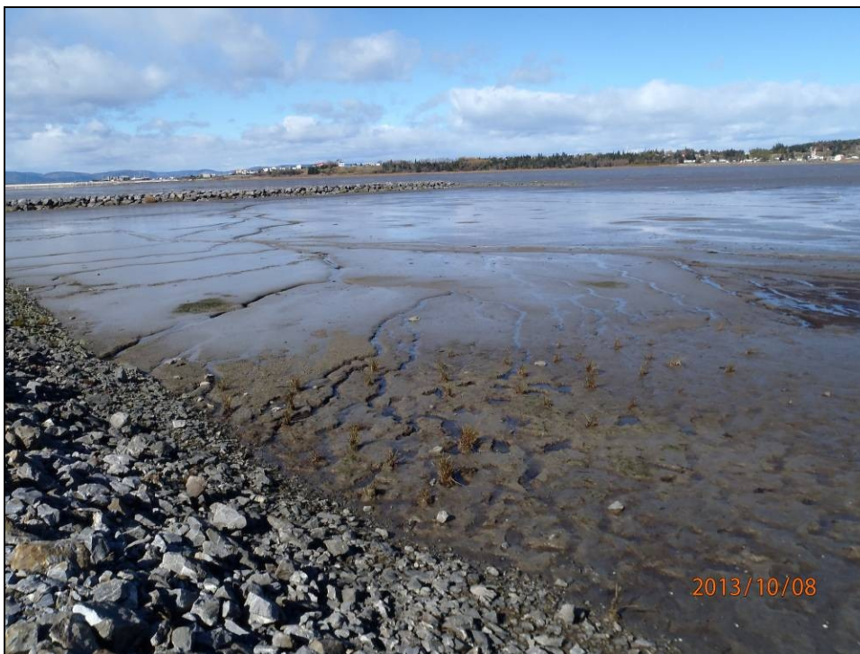
Photo 21 : Détail du côté nord-est de la digue, octobre 2013
