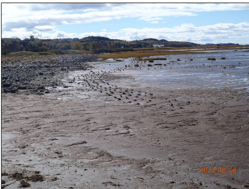
Photo 22 : Détail du côté sud-ouest de la digue côté plage, octobre 2013. Une zone de plantation de spartine est présente en marge de la rive. Le succès de reprise est intéressant.
