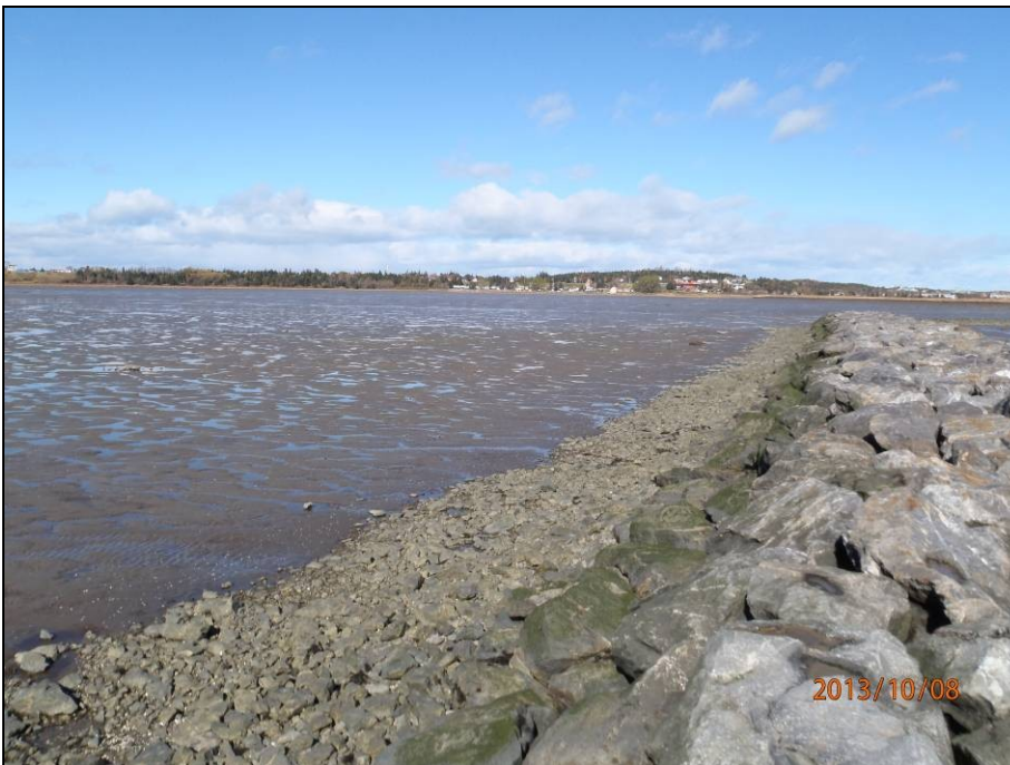
Photo 4 : Vue vers le nord-est et l'extérieur du brise-lames, 8 octobre 2013
