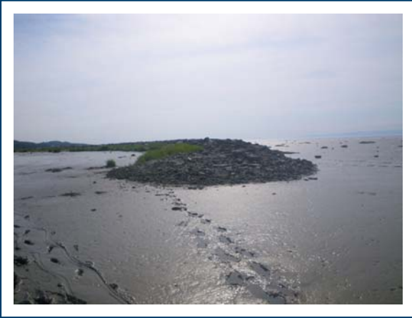
PHOTO 19 : Vue de l'ailette nord en direction du brise-lames, 24 août 2016
