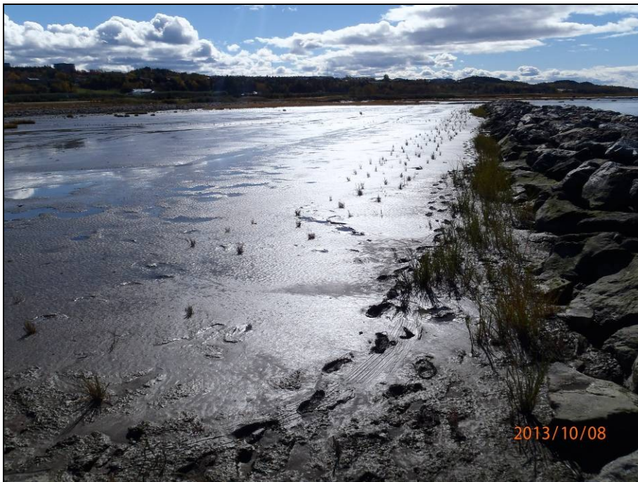
Photo 5 : Vue vers le sud-ouest et l'intérieur du brise-lames, 8 octobre 2013. Une zone de plantation de spartine est présente en marge du brise-lame.
