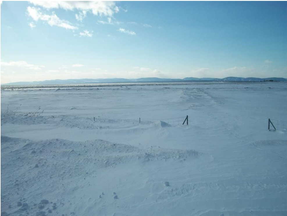
Photo 5 : Vue générale de la structure à marée haute, 17 mars 2014
