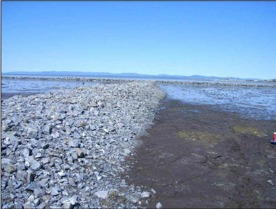
Photo 1 : Vue du côté nord-est de la digue transversale, 28 mai 2013
