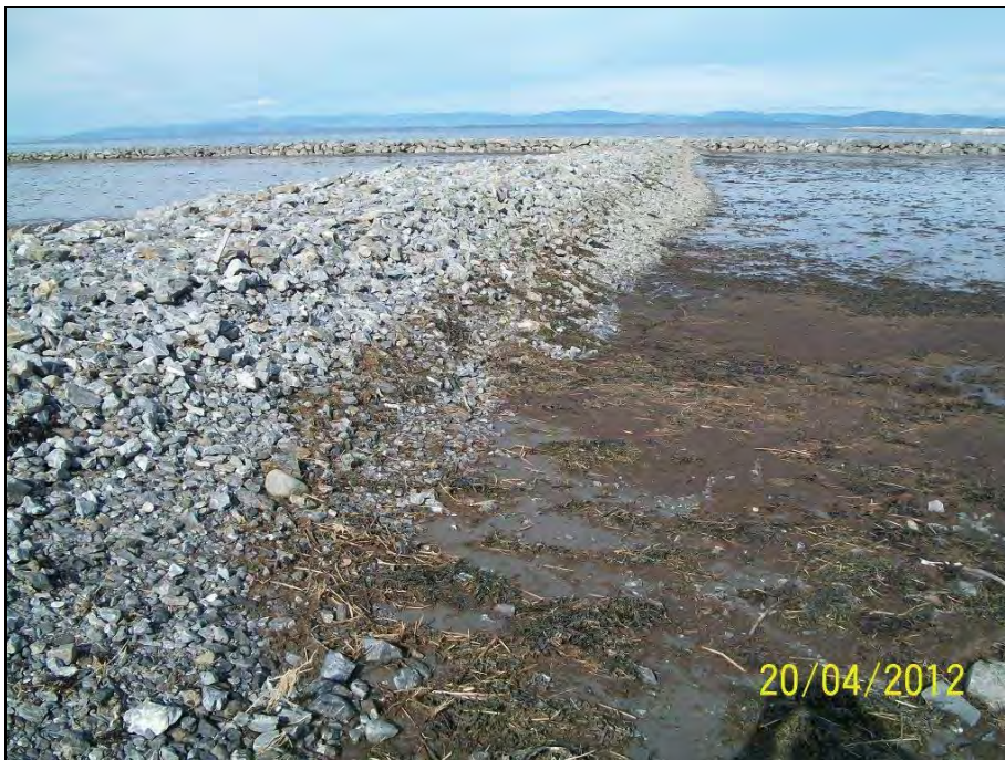
Photo 1 : Vue du côté nord-est de la digue transversale, 20 avril 2012
