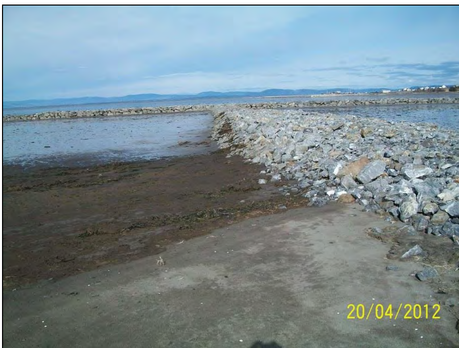
Photo 2 : Vue du côté sud-ouest de la digue transversale, 20 avril 2012
