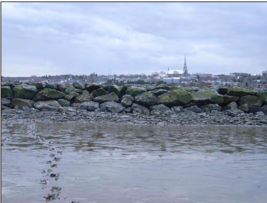
Photo 9 : Vue de l'extérieur de la digue parallèle à la rive, 8 mai 2012
