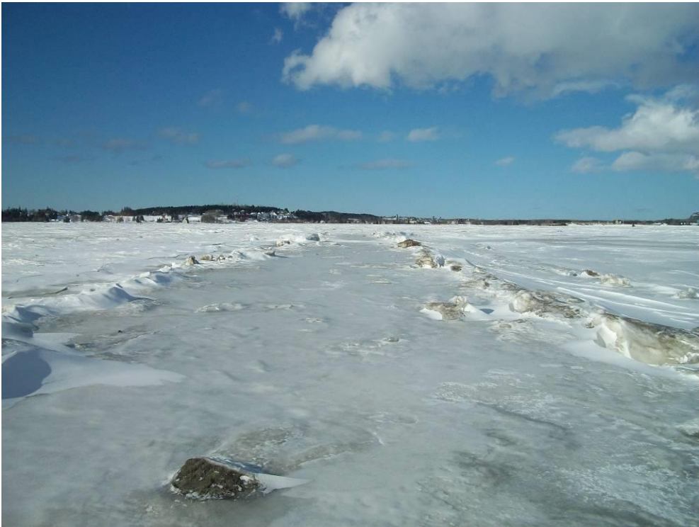
Photo 3 : Vue de la portion nord-est du brise-lames à marée haute, 17 mars 2014
