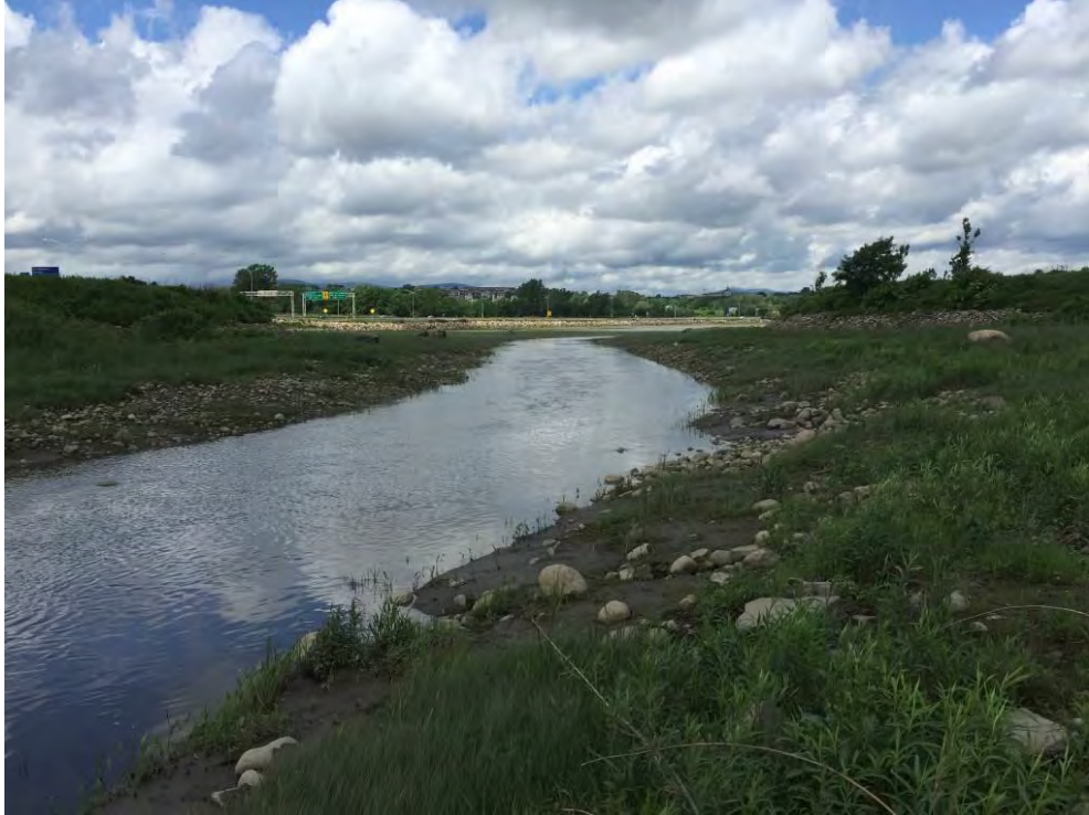
Photo 1 – Ruisseau du Moulin, vers l'aval à marée basse (2017-06-20)
