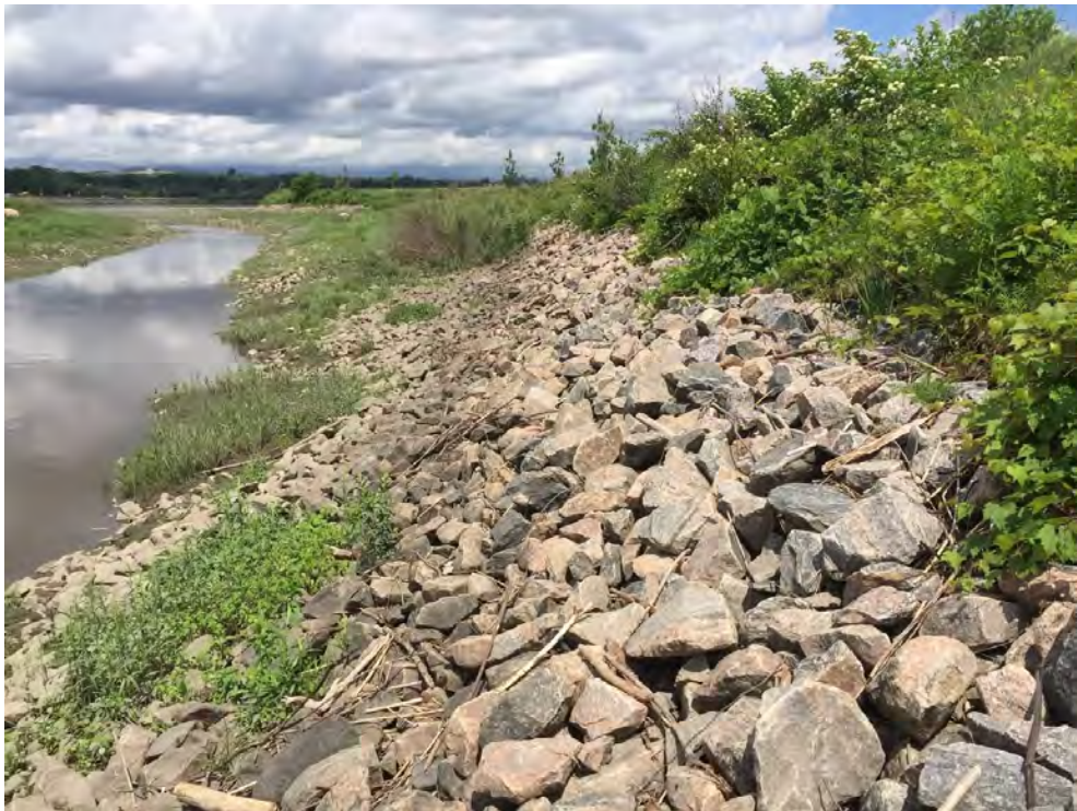
Photo 22 - Enrochement du portique et talus végétalisé
