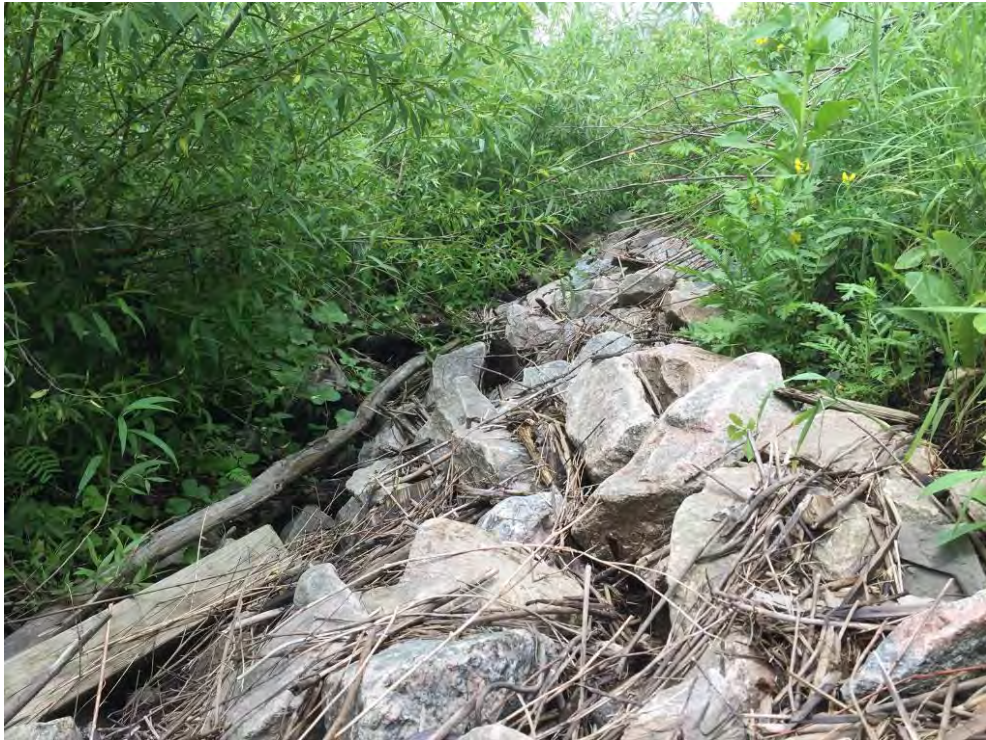
Photo 4 – Base du talus enroché et végétalisé (2017-06-20)
