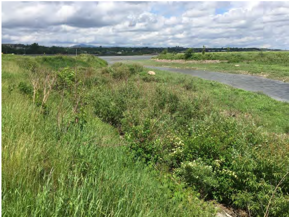
Photo 8 – Vue d'ensemble du marais et talus, vue vers l'aval à marée basse (2017-06-20)
