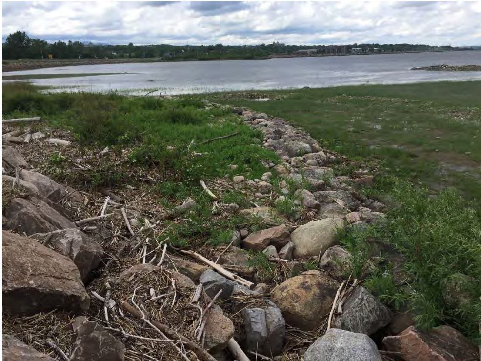
Photo 20 - Tablette ou palier, section avale, côté Ouest
