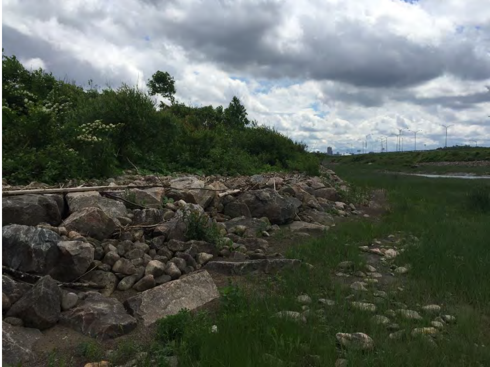
Photo 21 - Tablette ou palier, section aval, côté Est
