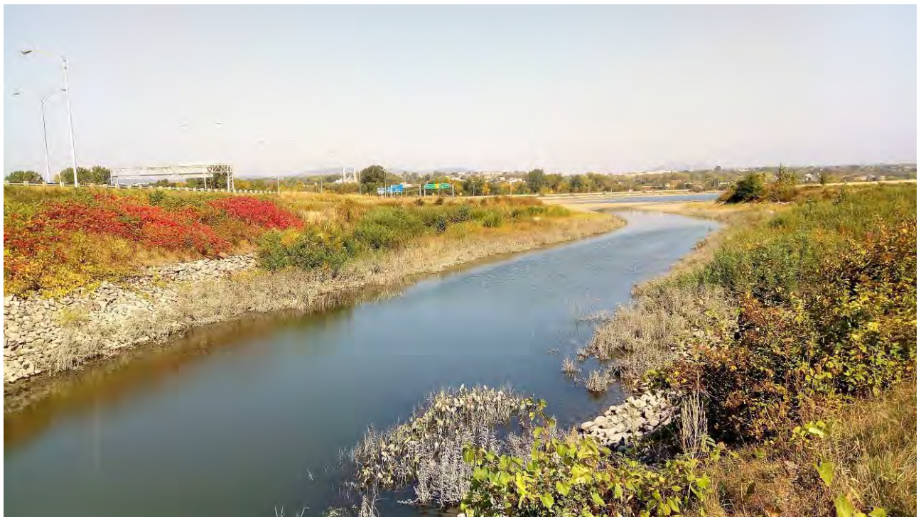
Figure 4 - Vue générale vers l'aval à marée intermédiaire (2017-09-26)
