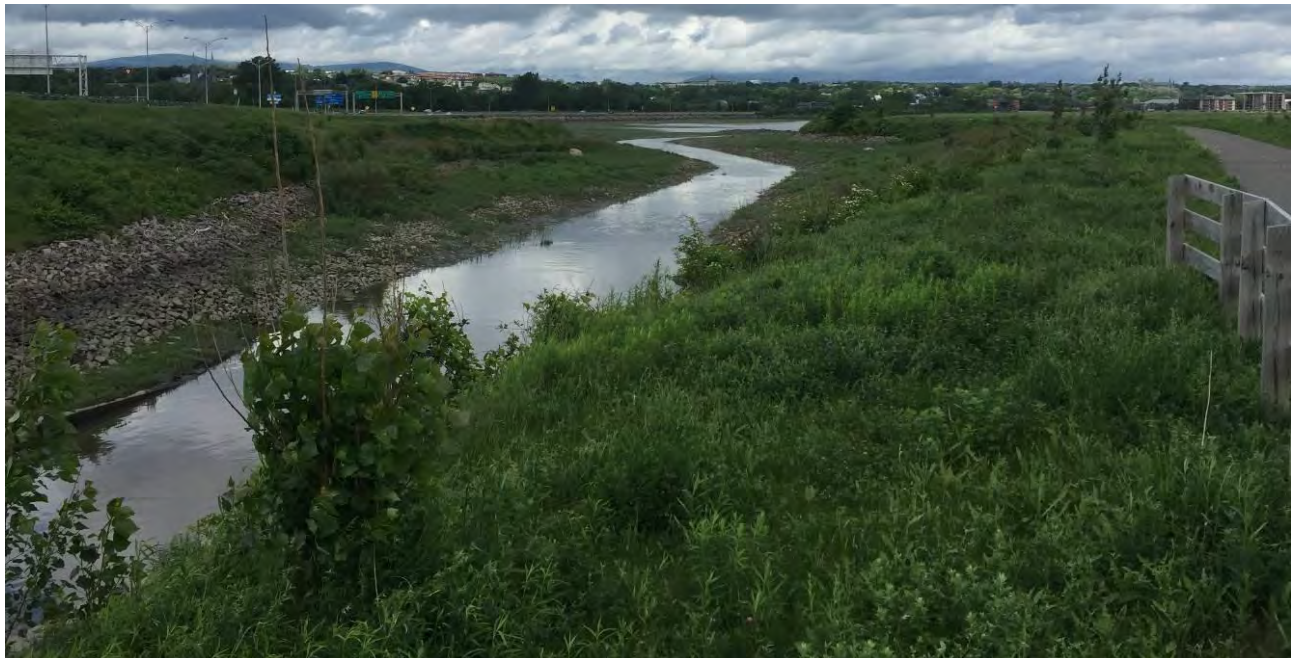
Figure 2 - Vue générale vers l'aval à marée basse (2017-06-20)
