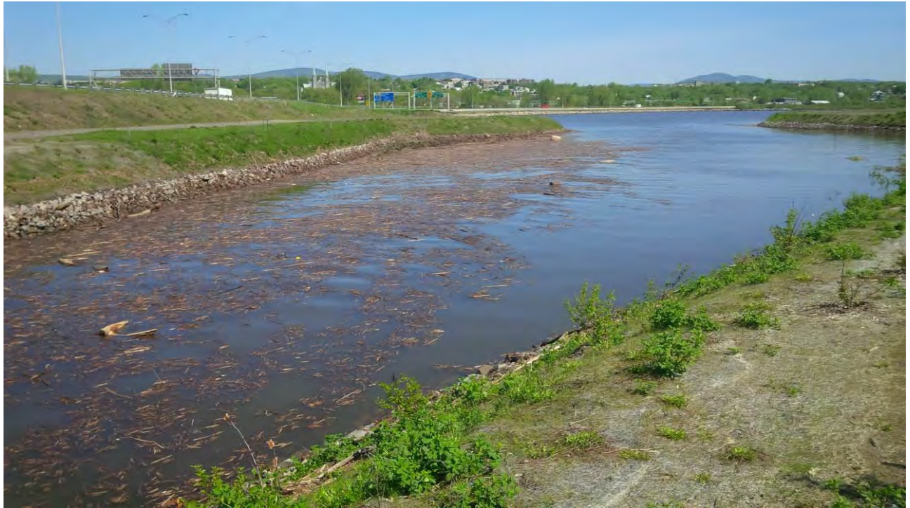
Figure 3 - Vue générale vers l'aval à marée haute (2013-05-28)
