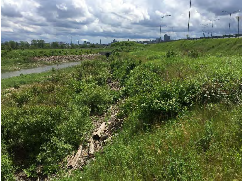
Photo 9 - Vue d'ensemble du marais et talus, vue vers l'amont à marée basse (2017-06-20)
