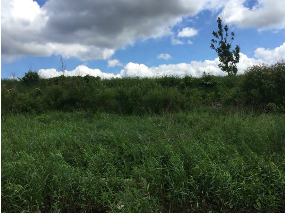
Photo 5 - Talus enroché et végétalisé avec végétation dense à la base (2017-06-20)
