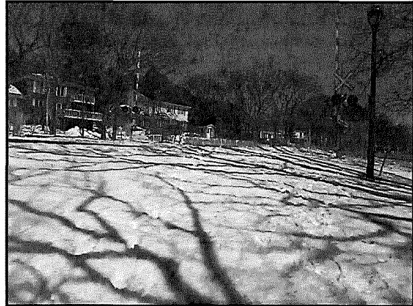
Vue en direction nord-est de la voie ferrée et des résidences situées en haut de la falaise.
