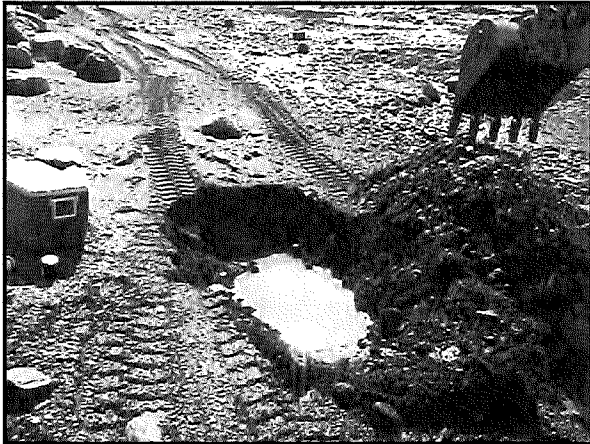
Réalisation de la tranchée d'exploration 15TE9.
