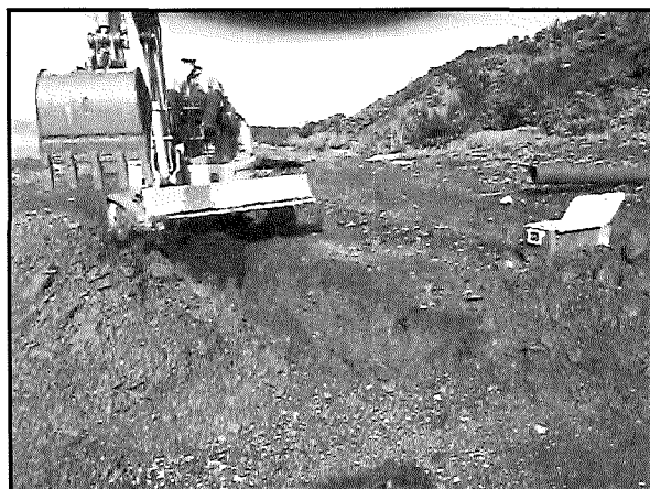
Réalisation de la tranchée d'exploration 15TE3.
