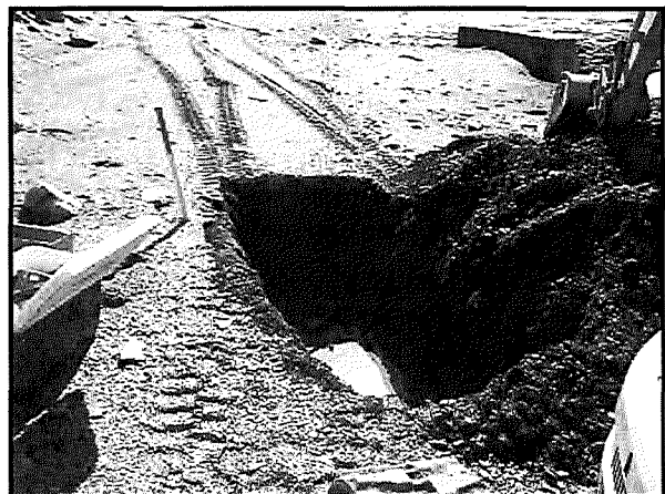
Réalisation de la tranchée d'exploration 15TE8.
