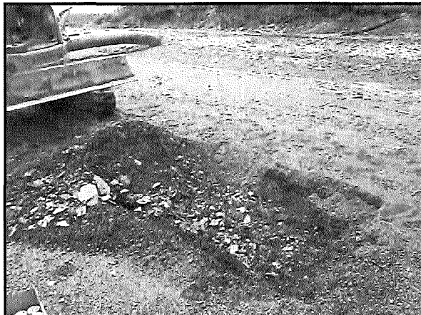
Réalisation de la tranchée d'exploration 15TE1.
