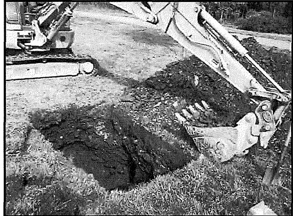
Réalisation de la tranchée d'exploration 15TE6.
