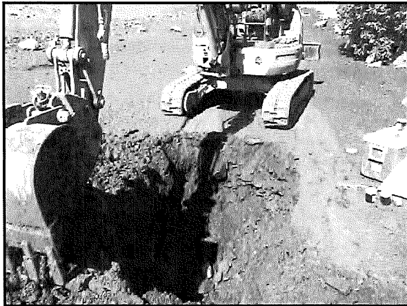
Réalisation de la tranchée d'exploration 15TE11.
