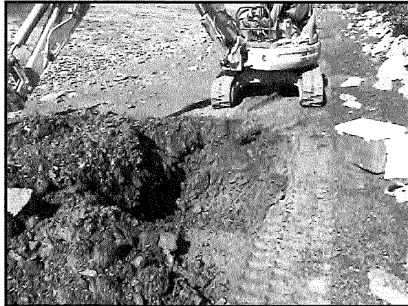
Réalisation de la tranchée d'exploration 15TE10.
