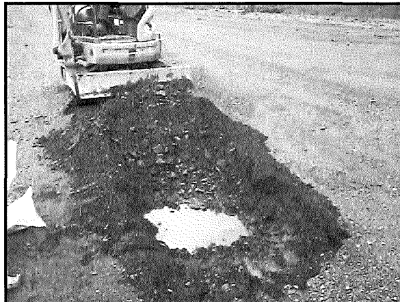
Réalisation de la tranchée d'exploration 15TE2.
