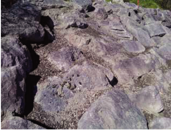
Fig. 73 - L'enrochement après le comblement des vides.
