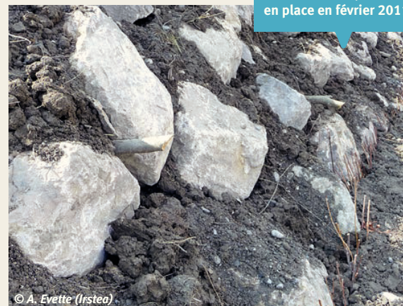
3 Enrochement végétalisé à l'avancement, à sa mise en place en février 2011.
