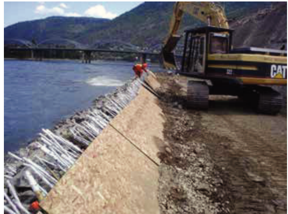
Fig. 80 - Positionnement des enrochements sur la partie supérieure.
