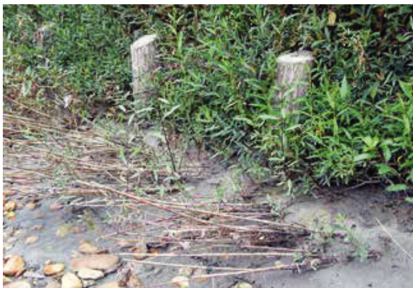
Fig. 11 - Piégeage des sédiments fins par les ramilles anti-affoulement, placées ici sous un ouvrage de protection de pied de berge, perpendiculairement au courant.
