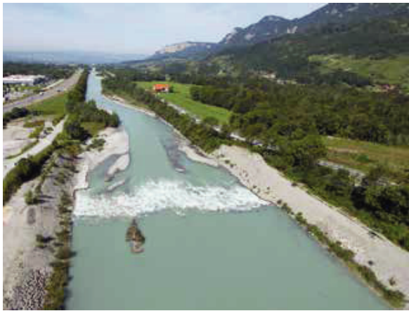
Fig. 69 - Vue aérienne du seuil, depuis l'amont, en septembre 2010. La berge de gauche est orientée nord et celle de droite est orientée sud. L'impact paysager et la discontinuité du corridor alluvial apparaissent clairement.
