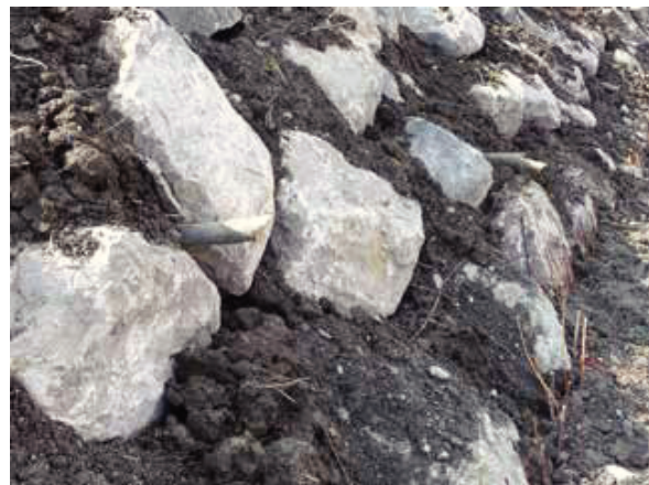
Fig. 76 - Mise en place de l'énrochement végétalisé en février 2011.
