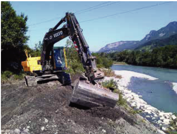
Fig. 74 - Placage de la terre à la pelle mécanique.
