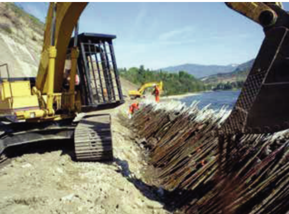
Fig. 79 - Mise en place des boutures et de la terre végétale.
