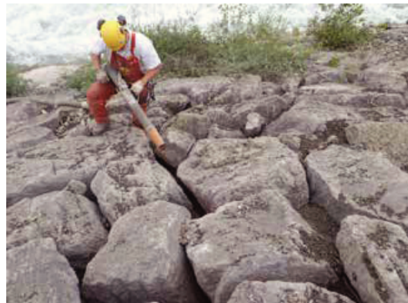
Fig. 72 - La lance garantit un remplissage des interstices en profondeur.
