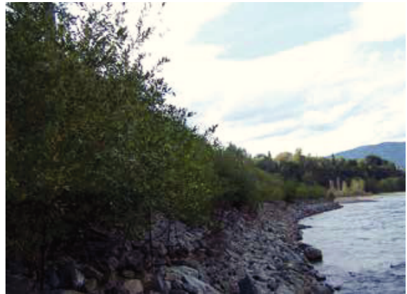
Fig. 81 - L'ouvrage 4 ans après les travaux.
