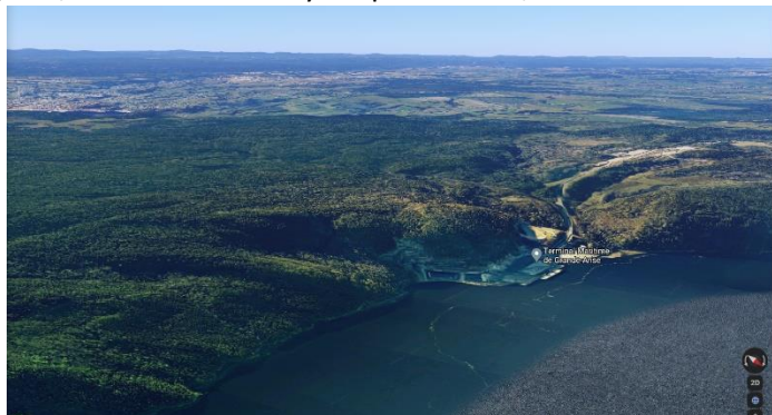
Figure 1- Vue aérienne virtuelle du port de Grande-Anse (Google Maps, Maxar Technologies, CNES / Airbus, City of Saguenay, CNES/ Airbus, Maxar Technologies, Landsat / Copernicus, Communauté Métropolitaine de Québec, NOAA, Data SIQ, NOAA U.S. Navy, NGA, GEBCO, Images © 2020 CNES, / Airbus City of Saguenay, Landsat / Copernicus, Maxar Technologies, Données cartographiques © 2020)
