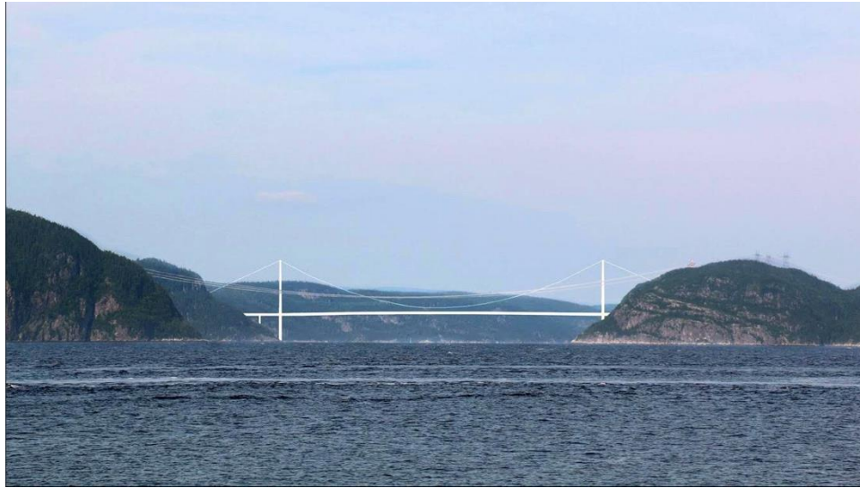
Implantation du pont au site de La Boule avec les deux piliers en rive au sec
