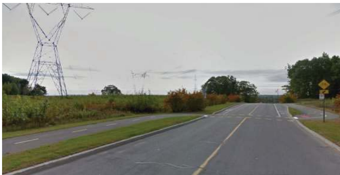
Photo 7.27 Paysage de corridor de lignes hydroélectriques. Vue depuis la rue de Plaisance, vers le sud, près de la rue d'Amiens.
