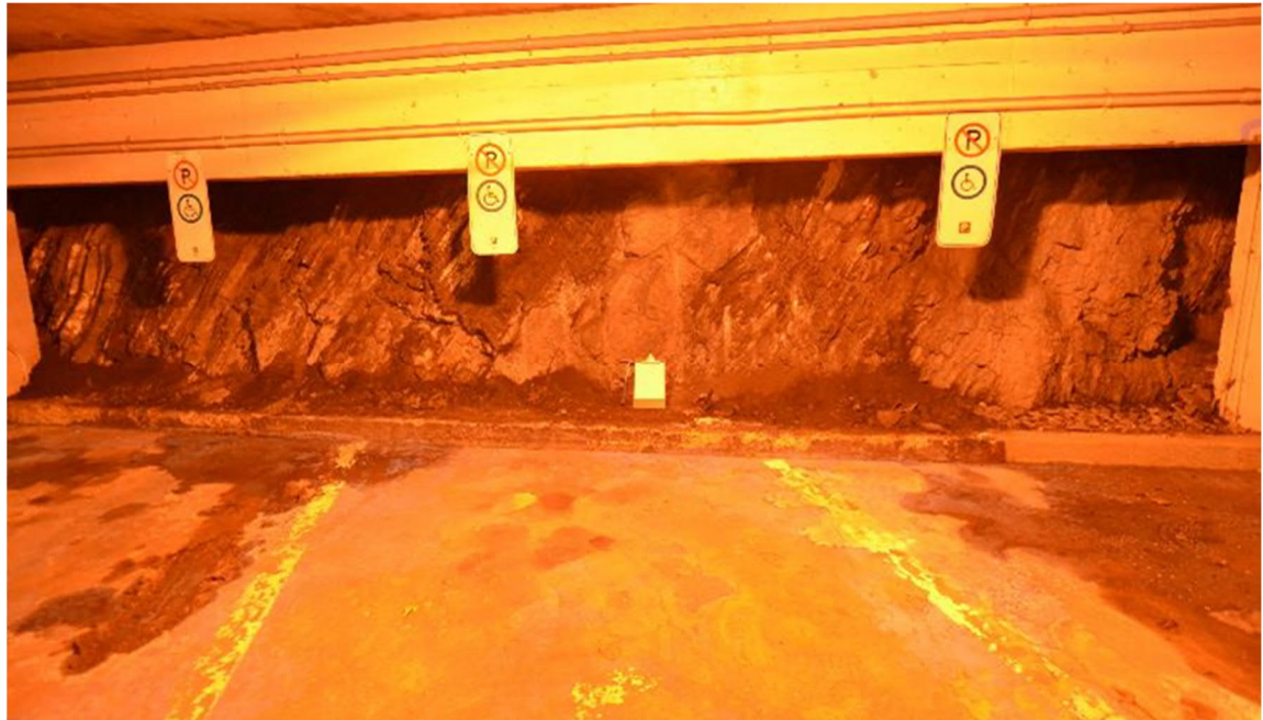
Figure 3-3 – Photo – Stationnement de la Place D'Youville
