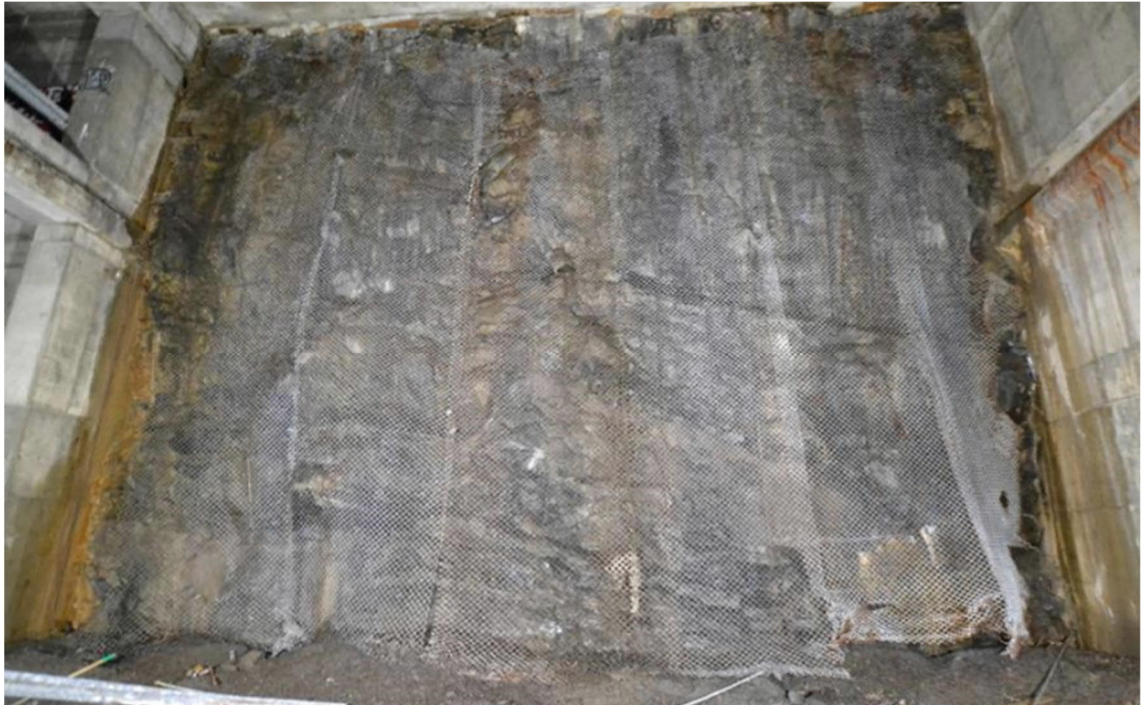
Figure 3-2 – Une des parois de roc du tunnel Dufferin
