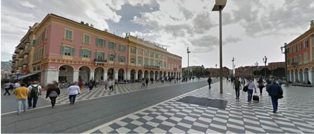
A Nice, la place Masséna, classée en terme patrimonial, interdit l'utilisation des caténaires et oblige à passer en alimentation électrique par le sol. La montée et descente du pantographe du tramway se fait en station de part et d'autre de la place.
