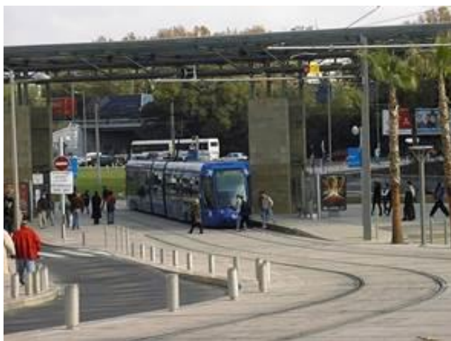
Exemple de plateforme dédiée au tramway
