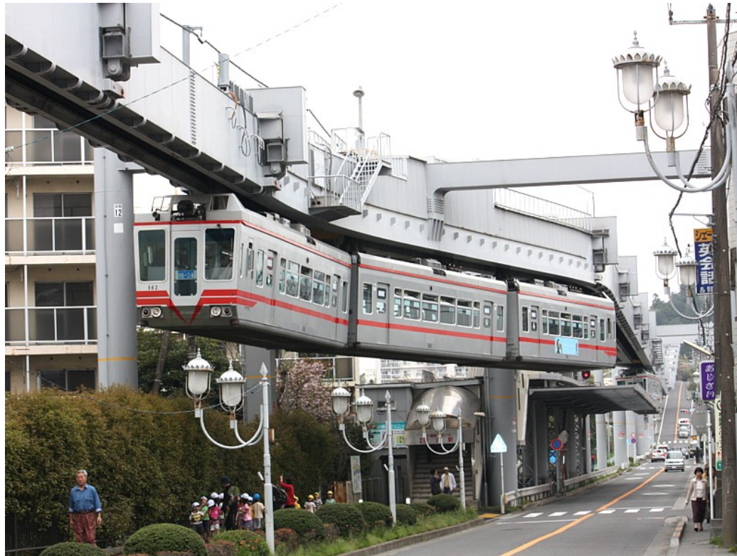
Monorail de Shonan au Japon (par Mitsubishi) : remarquez les pentes et l'intégration au paysage
