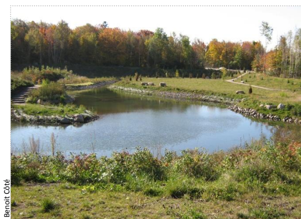
BASSIN LOIRET N° 25, PARC DE LA MONTAGNE DES ROCHES EXEMPLE CONFIGURATION NATURELLE, PROFIL VARIABLE
