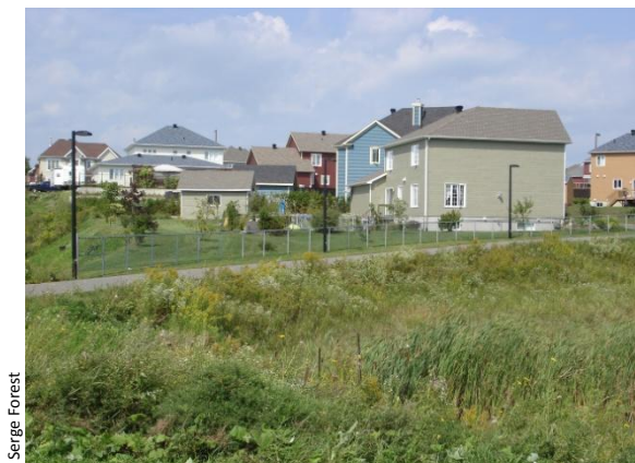
BASSIN CHAUVEAU N° 99 EXEMPLE CLÔTURE
