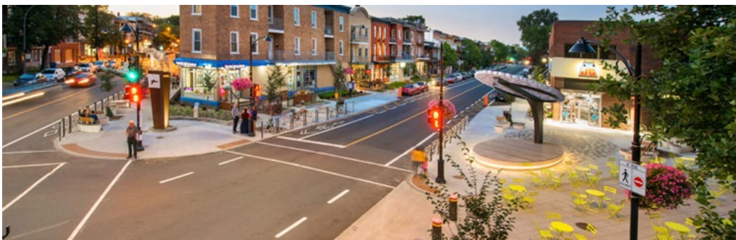
Chemin de la Canardière, réaménagement réalisé en 2017-2018
