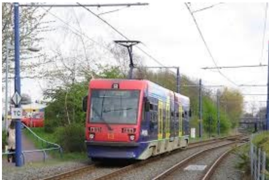
Le Metro de Midland, Royaume-Uni se départit partiellement de son caténaire upsbatterycenter.com
