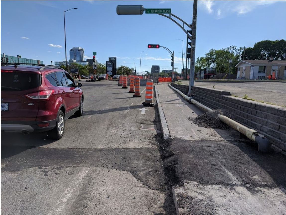
Figure 2 Travaux préliminaires au réseau de transport structurant sur le boulevard Hochelaga. Trottoir et piste cyclable barrées sur le boulevard Hochelaga. 9 juin 2020
