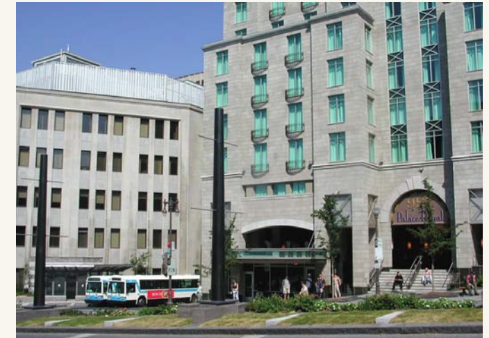
Abribus intégré à l'architecture : avenue Honoré-Mercier
