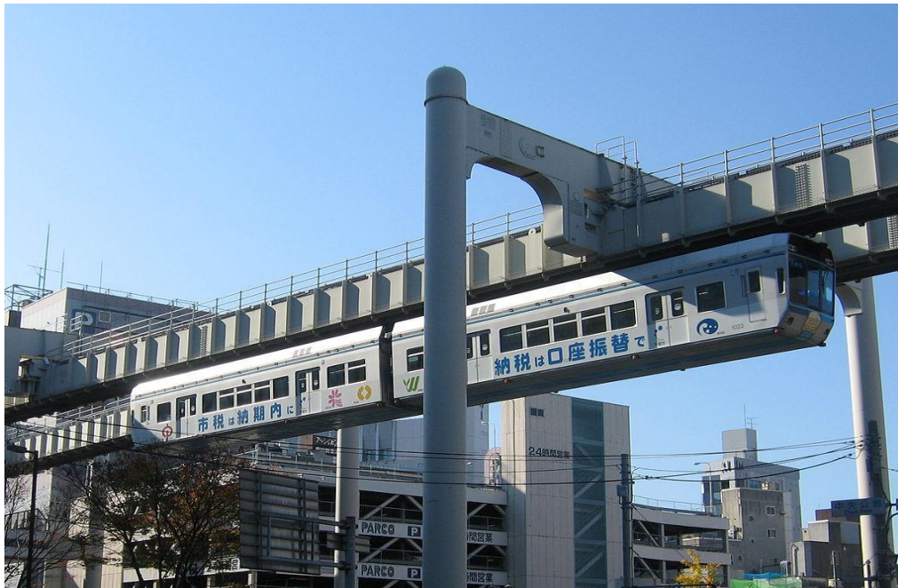
Monorail de Chiba au Japon (datant de 1979) : les poutres sont en U
