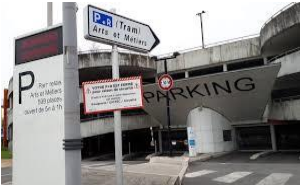
Photo de l'entrée d'un parc-relais à une station d'une rame du tramway bordelais
