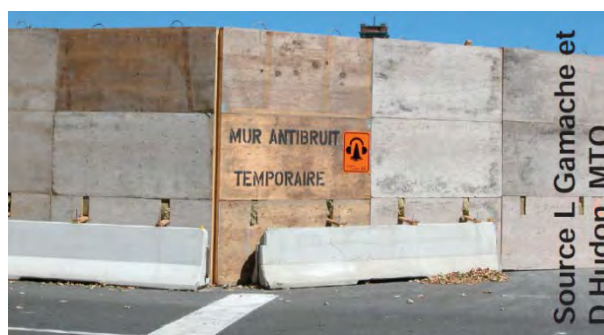
Photo 25 Écrans antibruit temporaires pour des chantiers de construction
