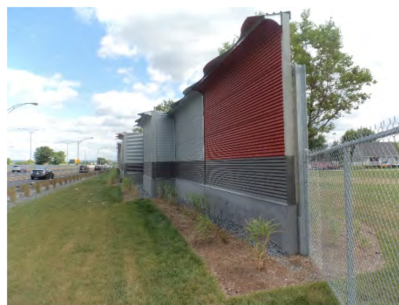
Vue du côté de la route.
