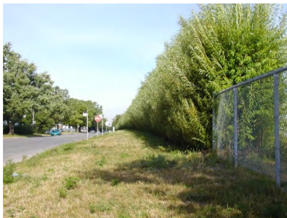
Mur-écran végétalisé installé le long d'une partie de l'autoroute 15, à Laval, le long de la rue Guillemette. Le mur est principalement constitué de terre retenue par une membrane géotextile qui s'insère dans une structure de bois. L'ensemble du mur est entouré de végétation (saule).
