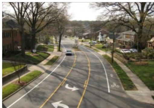
Transformation en une « rue complète » d'un boulevard à quatre voies non séparées (débit : 20 000 véhicules/jour) avec une voie centrale, des pistes cyclables et des rampes pour accéder aux trottoirs. Ville de Charlotte, Mecklenburg County (NC) : East Boulevard. Crédit photo : Charmcheck.org
