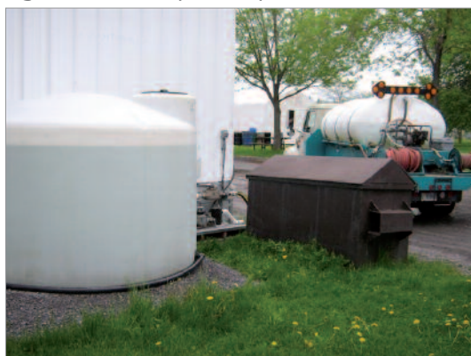
Figure 16-B : Récupération par camion-citerne.
