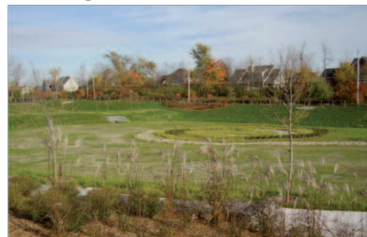
Figure 14-F : Bassin de rétention du Boisé.
