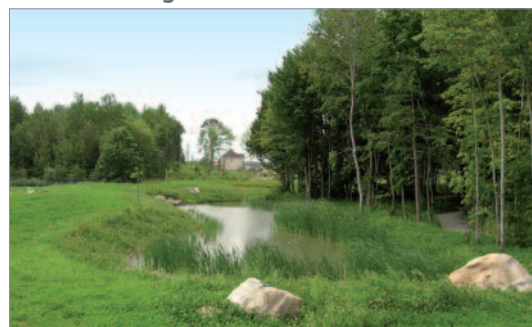
Figure 7-C : Bassin de forme naturelle.
