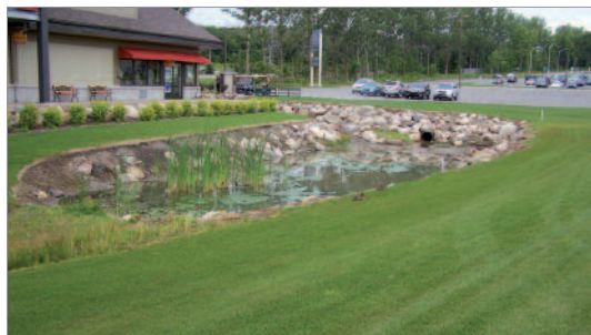
Figure 45 : Bassin dans un secteur commercial et institutionnel.
