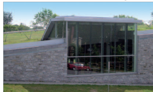
Figure 28 : Toiture de la bibliothèque de Charlesbourg, Québec.
