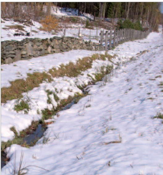
Figure 8-C : Fossé pouvant servir à la rétention.
