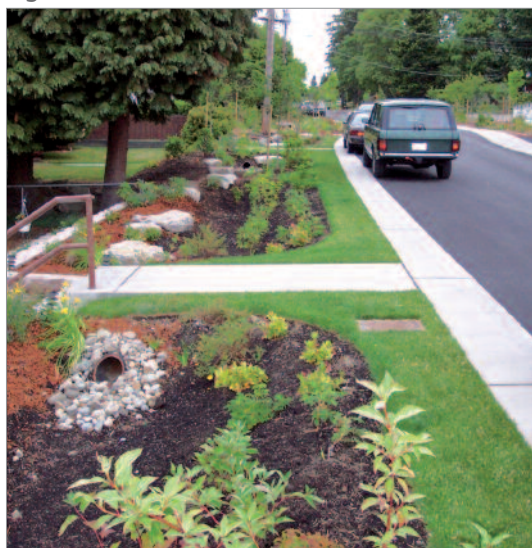
Figure 36 : Noue avec biorétention.
