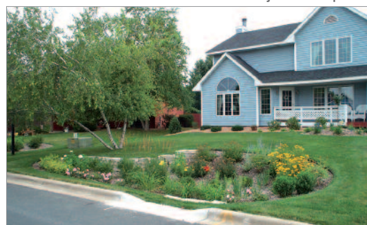
Figure 39 : Bordure ajourée permettant l'écoulement du ruissellement dans un jardin de pluie.
