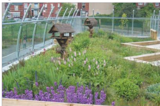
Figure 80 : Toit de l'école Sharrow.
