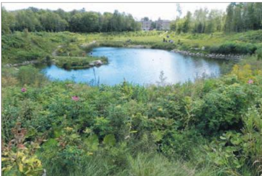
Figure 8-D : Bassin de rétention.
