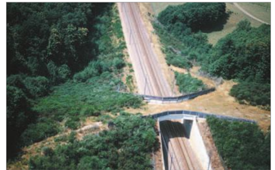
Figure 54 : Passage au-dessus d'une ligne de TGV.
