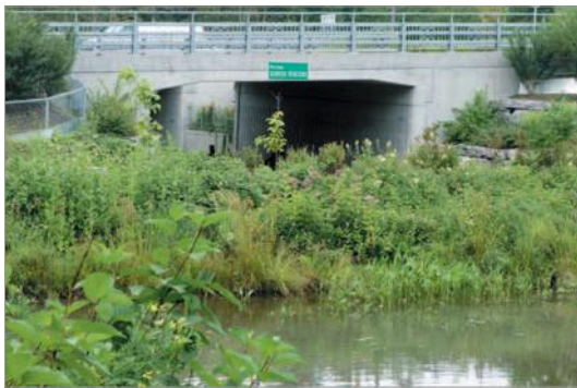
Figure 6-D : Étang de sédimentation.
