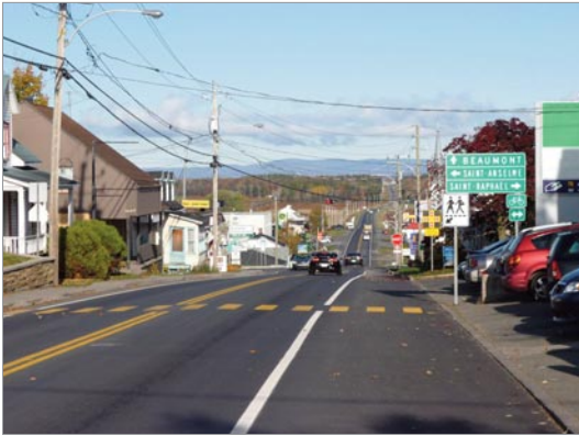
Figure 127 : Bande cyclable et traversée piétonne.
