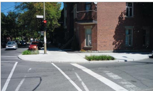
Figure 9-D : Avancée de trottoir.
