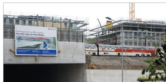
Figure 48 : Immeubles en construction près de la future halte de Prilly-Malley, Lausanne.
