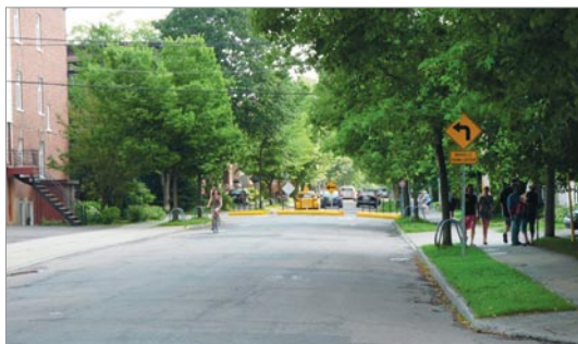
Figure 7-C : Terre-plein diagonal temporaire.
