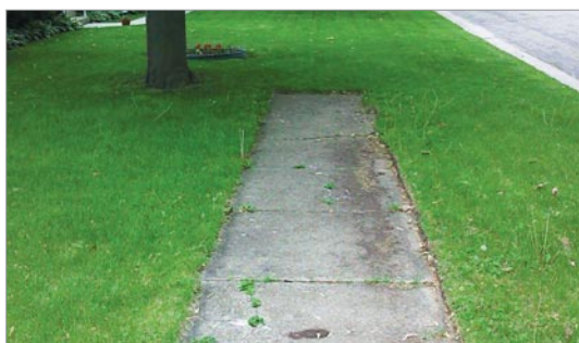
Figure 98 : Interruption du trottoir.
