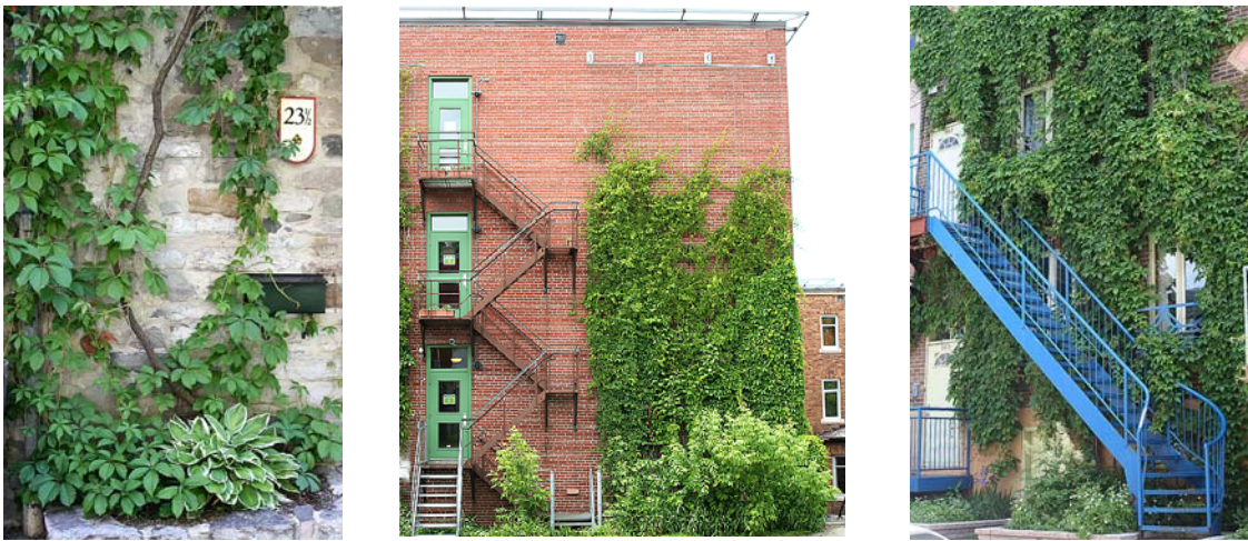
Figure 4 Murs végétaux de façade
