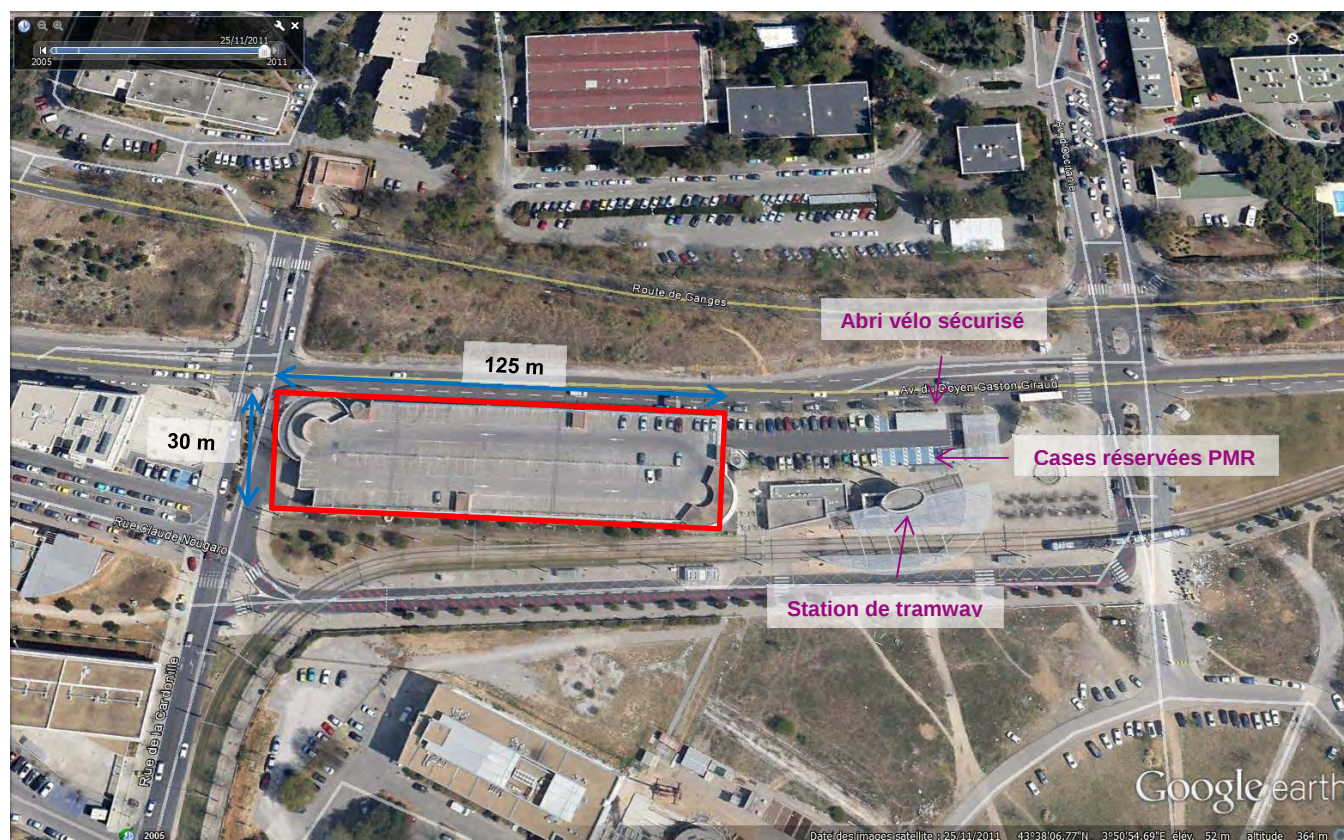
Figure 5-16 – Parc-O-Bus en ouvrage station Occitanie – Montpellier, France
