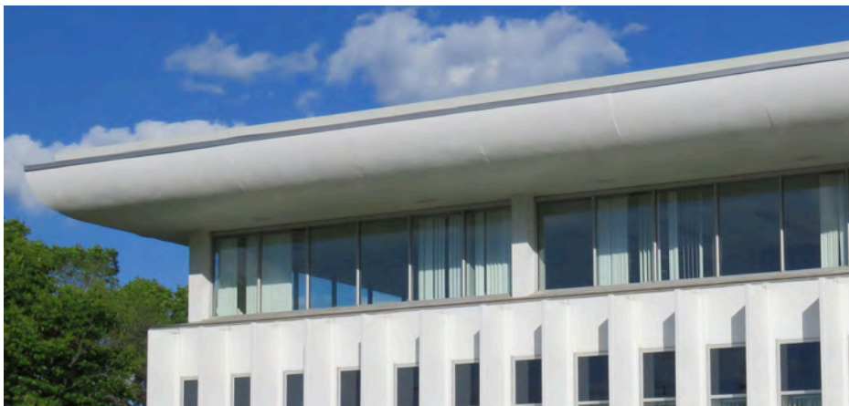
Extrémité de toiture en forme de coque renversée et bandeau de fenêtres à la partie supérieure des murs. Photo : IMG_2662.jpg
