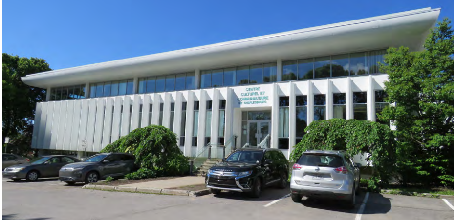
Centre communautaire et culturel de Charlesbourg. 7575, boulevard Henri-Bourassa. Façade principale. Photo : IMG_2438.jpg
