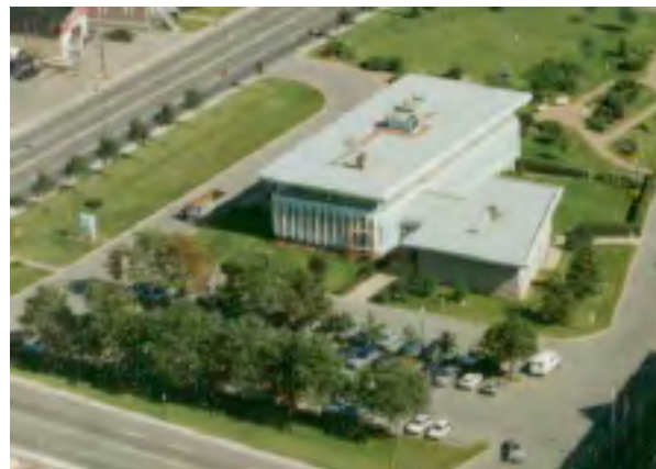
L'hôtel de ville de Charlesbourg et le bâtiment annexé qui abrite la salle du conseil. Vers 1990. Photo : Communauté urbaine de Québec. 90637.15. Répertoire DHN, Ville de Québec.
