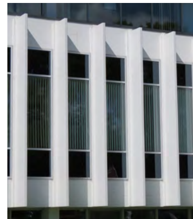
Bandes de béton faisant office de pare-soleil. Photo : IMG_2440.jpg
