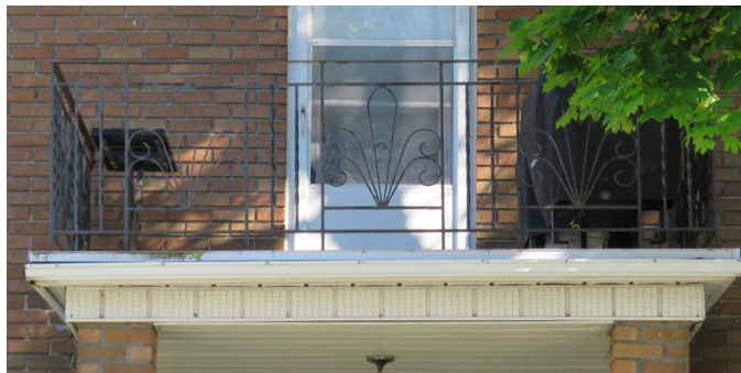
Garde-corps en fer ornemental. Photo : IMG_2688.jpg
