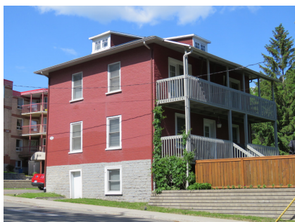
6050, 1 re Avenue. Façade sud et élévation ouest. Photo : IMG_2935.jpg
