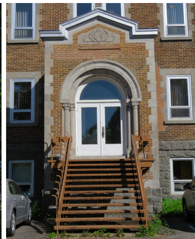
Portail en arc plein cintre et colonnes doubles engagées, façade sud. Photo : IMG_2694.jpg
