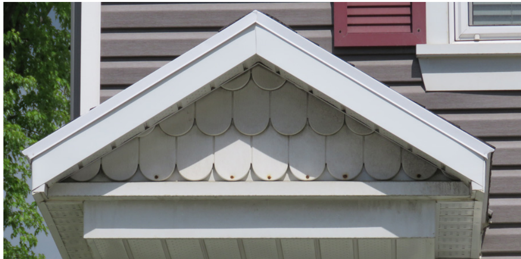
Bardeau de bois découpé au fronton du toit du balcon. Photo : IMG_2490.jpg
