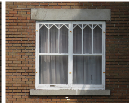
Fenêtres jumelées à guillotine. Photo : IMG_2460.jpg
