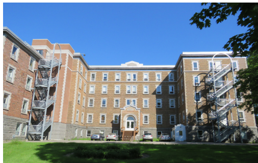
Couvent des pères Eudistes, 6125, 1 re Avenue. Photo : IMG_2935.jpg
