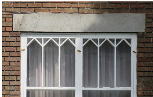
Linteau en pierre et fenêtres à petit-bois. Photo : IMG_2462.jpg
