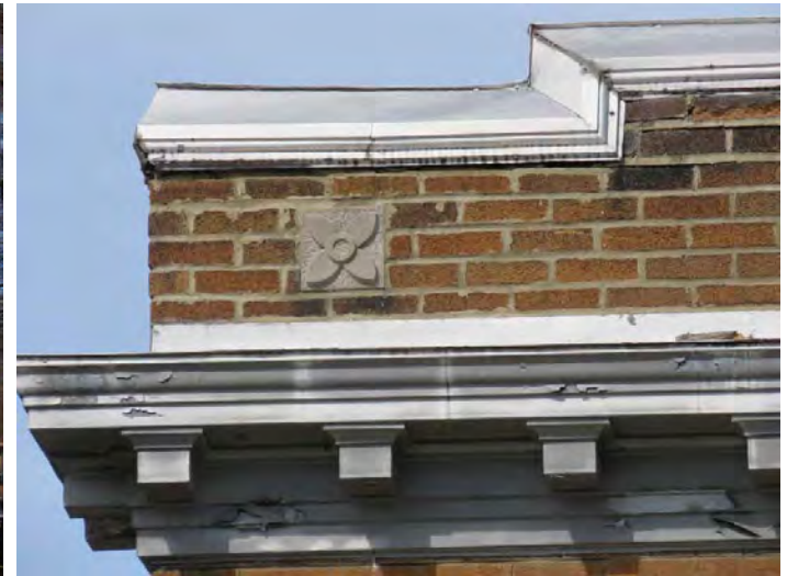
Corniche à ressauts du parapet, incrustation de pierre et corniche à modillons en bas. 1210-1214, 1 re Avenue. Photo : IMG_2058.jpg
