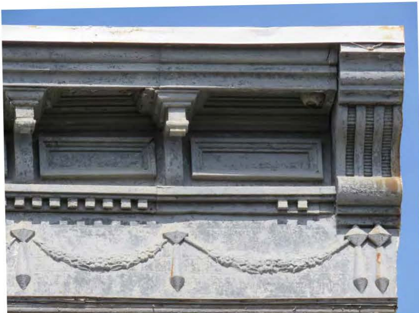
Corniche à consoles, avec moulures rectangulaires et guirlande de fleurs sur la frise et consoles d'arrêt à droite. 970-984, 1 re Avenue. Photo : IMG_1929.jpg
