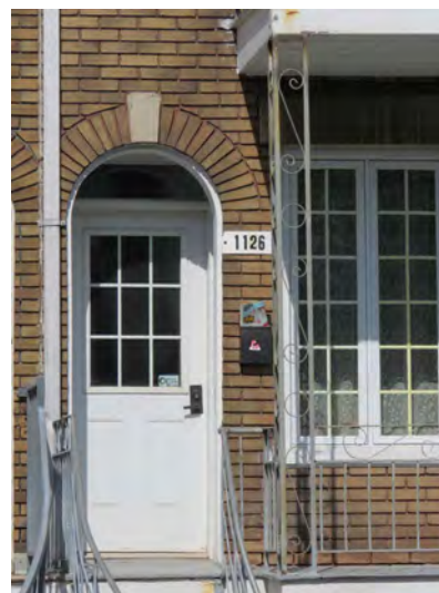
Arc plein cintre et imposte de même forme au-dessus d'une porte. 1120-1126, 1 re Avenue. Photo : IMG_2003.jpg
