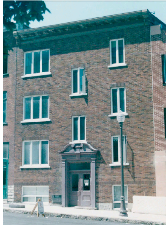
Façade principale du 880, rue Saint-Joachim en 1996. Ces fenêtres ont été mises en place huit ans auparavant. Répertoire DHN de la Ville de Québec.
