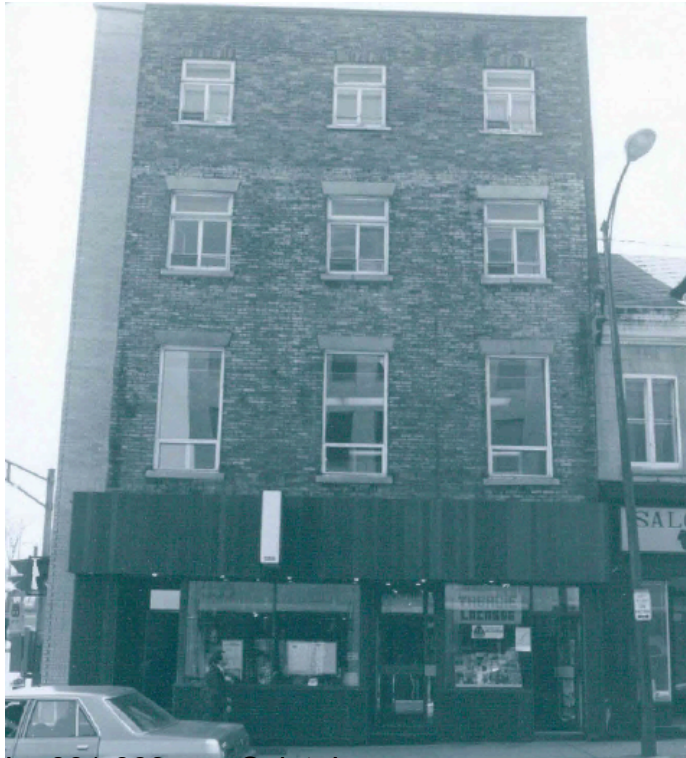
Le 881-883, rue Saint-Jean en 1982. Photo : Répertoire DHN, Ville de Québec
