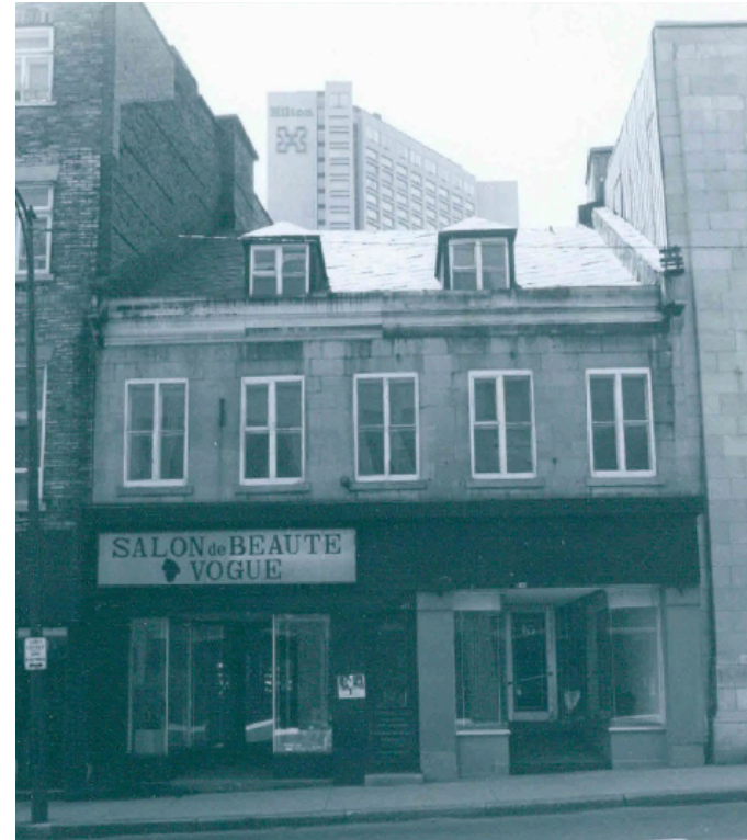
Le 875-879, rue Saint-Jean en 1982. Photo : Répertoire DHN, Ville de Québec
