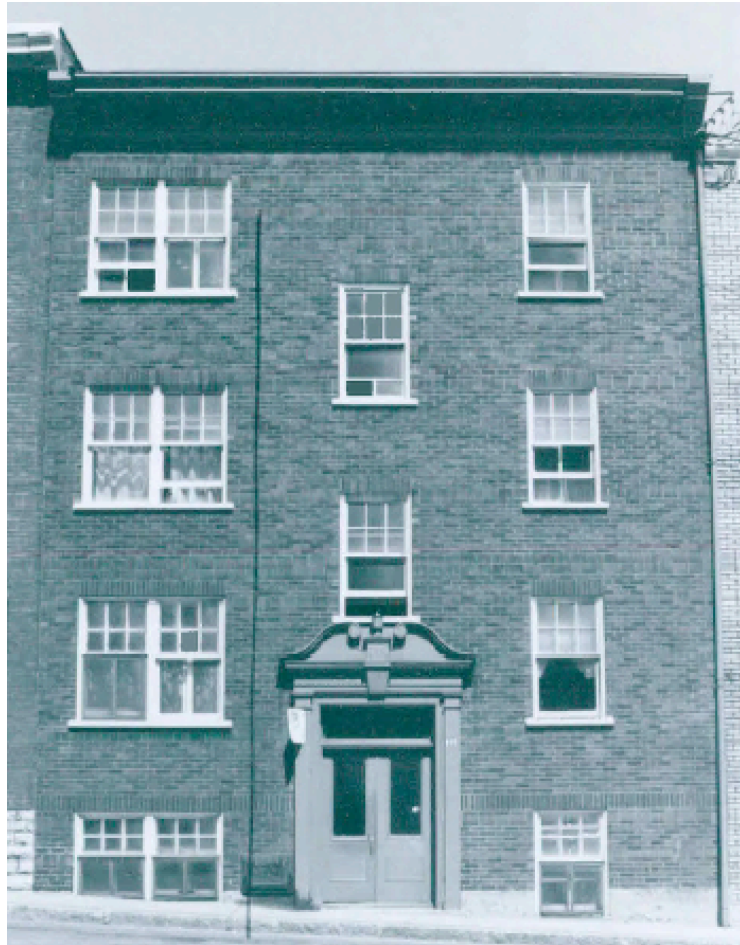
Façade principale du 880, rue Saint-Joachim. 1982. À ce moment, les fenêtres d'origine (à battants intérieurs et à guillotine extérieure) et l'urne au centre du fronton brisé de la porte sont encore en place. Répertoire DHN de la Ville de Québec
