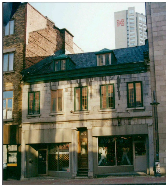
Le 875-879, rue Saint-Jean en 1993. Photo : Répertoire DHN, Ville de Québec
