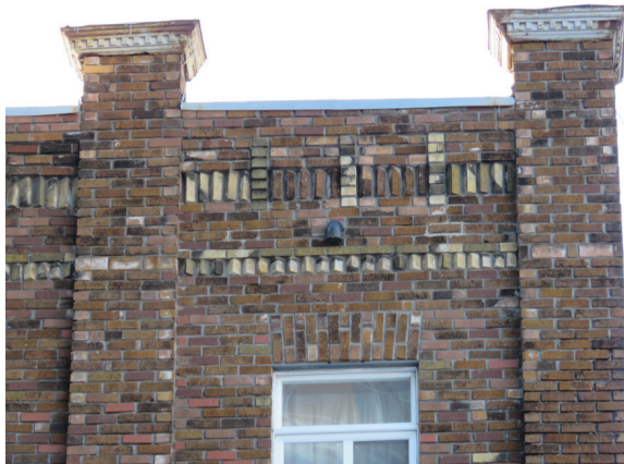
Sommet de pilastre et couronnements en brique. IMG_9101.jpg
