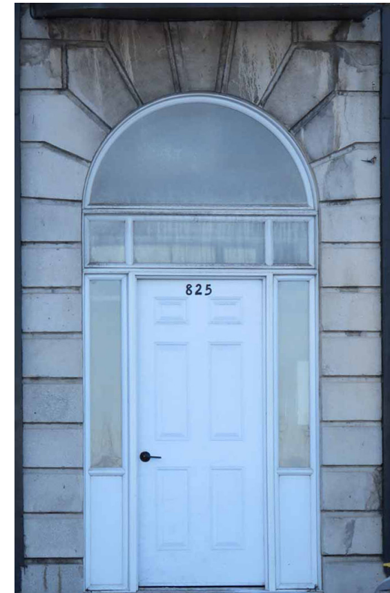
Encadrement en pierre autour de la porte principale. IMG_9189.jpg
