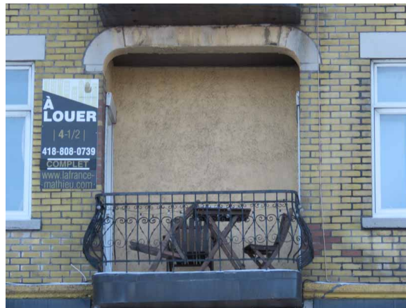
Balcon en forme de loggia et garde-corps en fer ornemental, probablement d'origine. IMG_9188.jpg
