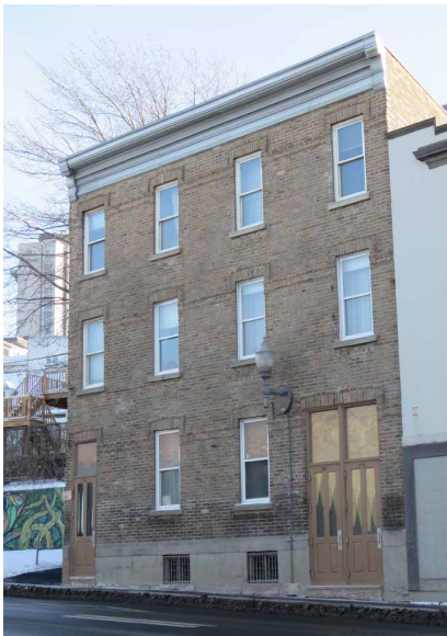
Façade avant. IMG_9166.jpg
