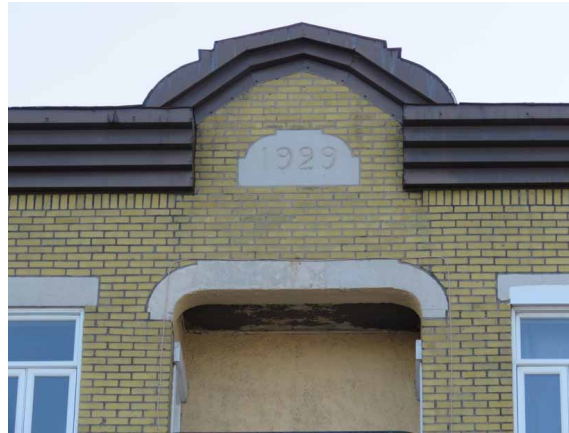
Millésime et linteau en arc en anse de panier en pierre de taille, surmontant le balcon du second étage. IMG_9178.jpg
