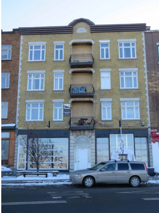
Façade avant. IMG_9185.jpg
