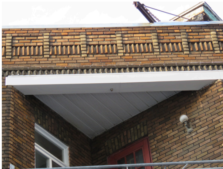
Corniche à modillons surmontant les couronnements en brique. IMG_9102.jpg
