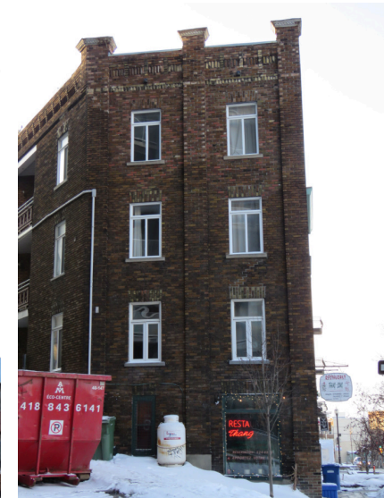
Élévation est. IMG_9098.jpg
