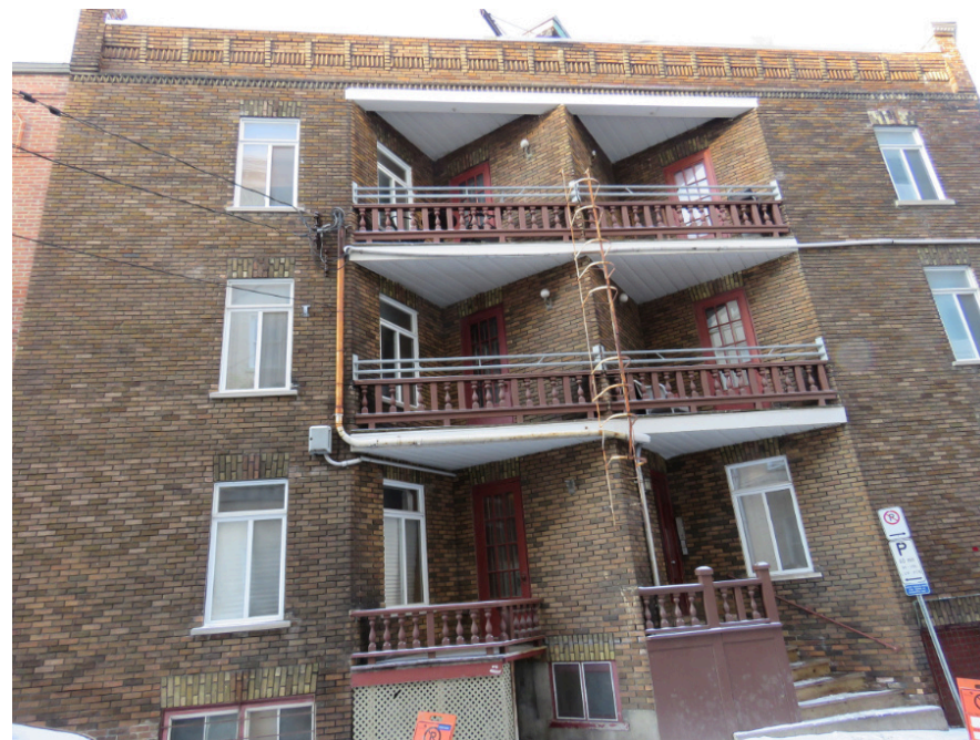
Façade longéant la rue Richelieu. IMG_9089.jpg
