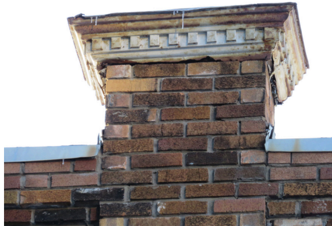
Corniche à modillons surmontant les couronnements en brique. IMG_9102.jpg
