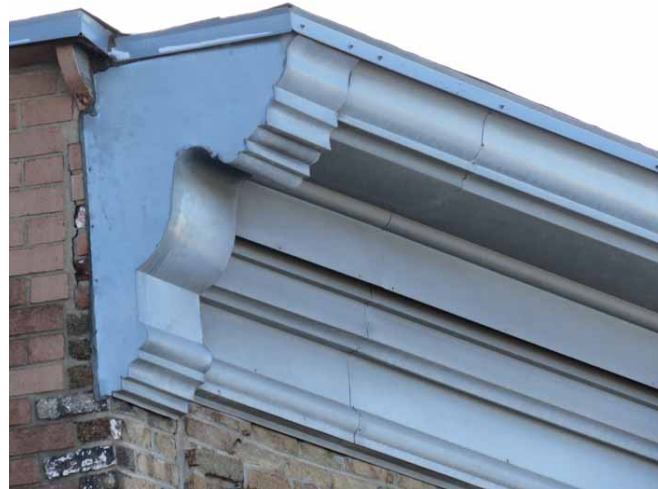
Corniche moulurée et console d'arrêt. IMG_9175.jpg
