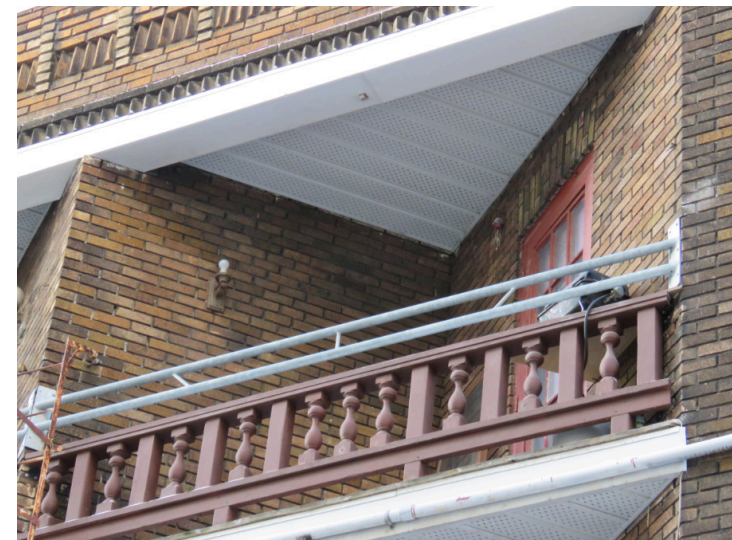
Balcon et mur de forme triangulaire. Le garde-corps intègre balustres et barreaux. IMG_9096.jpg
