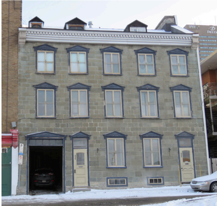
Façade avant. IMG_9055.jpg
