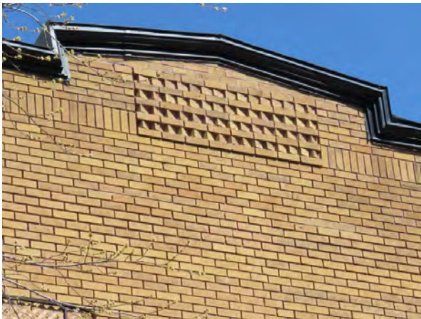
Corniche à ressauts en bordure du toit. 985, avenue Calixa-Lavallée.
