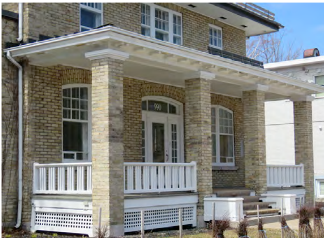
Galerie avec colonnes de brique et toit orné de modillons. 990, avenue Holland.
