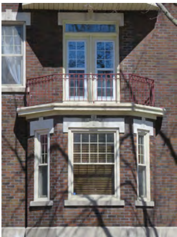
Logette surmontée d'un balcon (à gauche). Arc en bordure du toit de la galerie au-dessus du perron (à droite). Linteaux de fenêtre avec clé au centre. 1015, avenue Brown.
