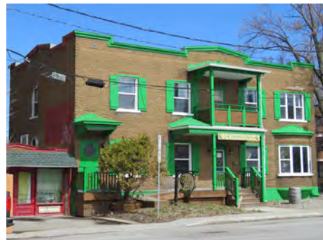
Maison à toit plat. 966-980, boulevard René-Lévesque Ouest.
