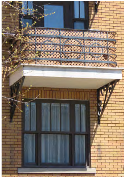
Garde-corps et consoles de balcons en fer ornemental. Porte à baies latérales et à imposte. Fenêtres à petit-bois à imposte et à baies latérales. 985, avenue Calixa-Lavallée.
