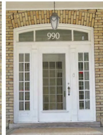
Porte à baies latérales et à imposte. 990, avenue Holland.
