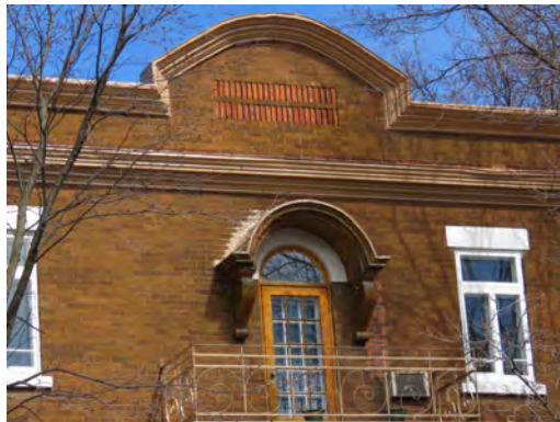
Couronnement en arc surbaissé et corniche à ressauts. En bas : arc plein cintre au-dessus de la porte du balcon.
