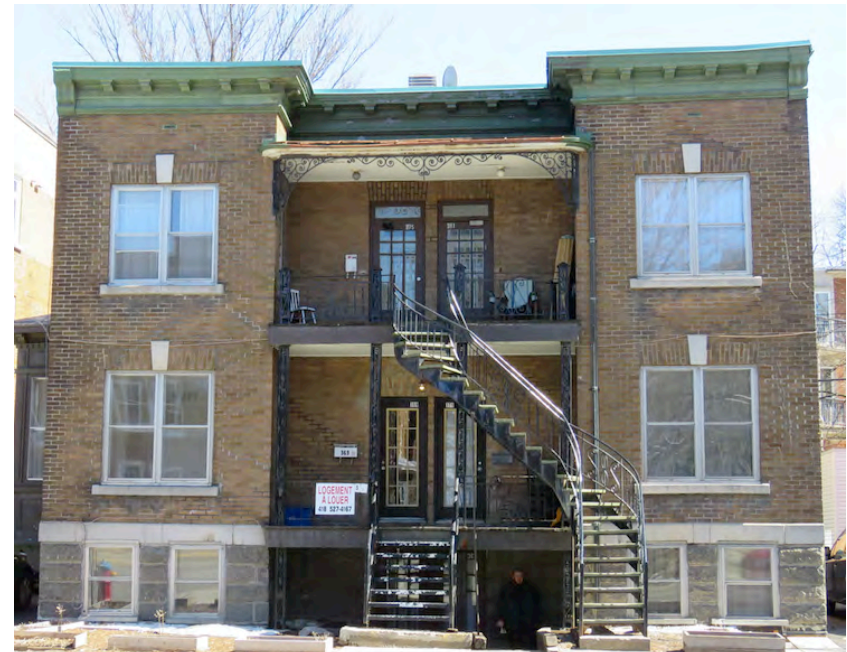
Plex doté de ses escaliers distinctifs. Corniche à consoles. Linteau en brique avec clé en pierre au-dessus des fenêtres. 365-381, boulevard René-Lévesque Ouest.
