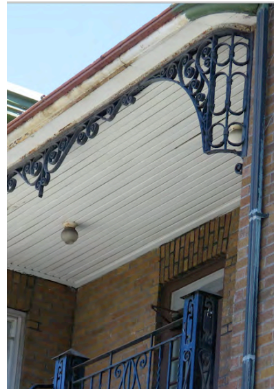
Détail de la garniture en fer ornemental en bordure du toit du balcon. 365-381, boulevard René-Lévesque Ouest.
