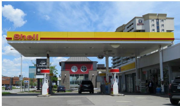
Marquise au-dessus des pompes à essence.
