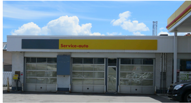
Façade avant de la partie est de la station-service.
