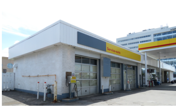
Mur latéral est et façade avant. Mur en brique.
