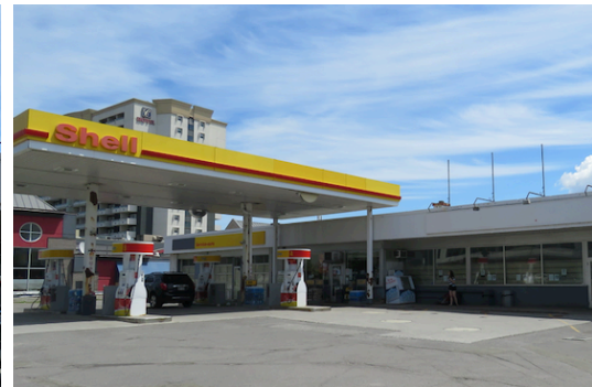
Marquise et façade avant de la partie de la station-service.
