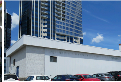
Élévation ouest et arrière de la station-service. Brique et revêtement en acier émaillé.
