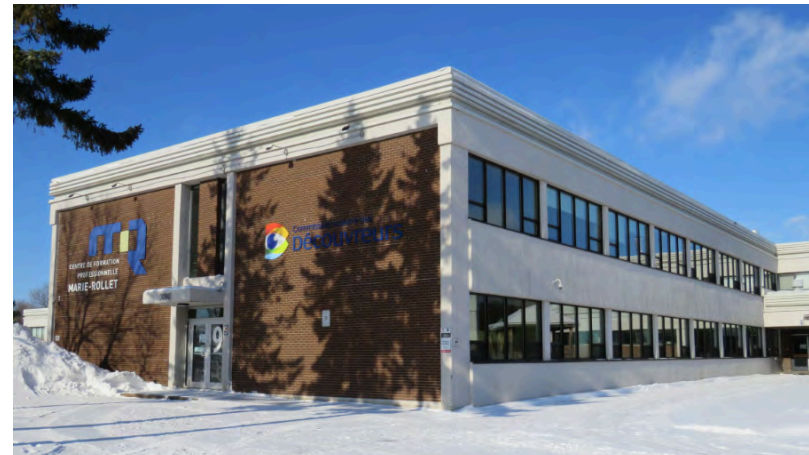
Aile sud – Entrée principale. IMG_8970.jpg
