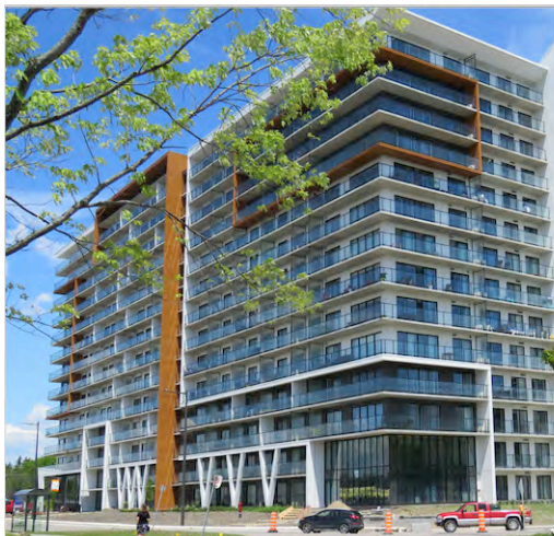
Édifice Le Sommet, 935, avenue Roland-Beaudin.
