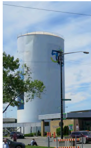
Le château d'eau de Sainte-Foy.
