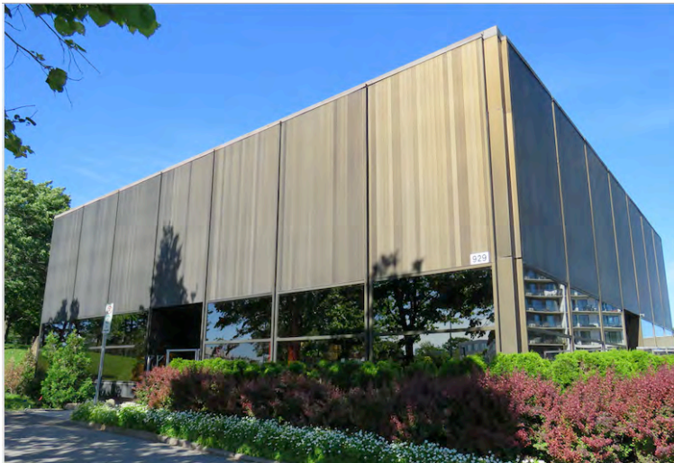
Deux des quatre élévations identiques de la station de pompage du parc Roland-Beaudin.
