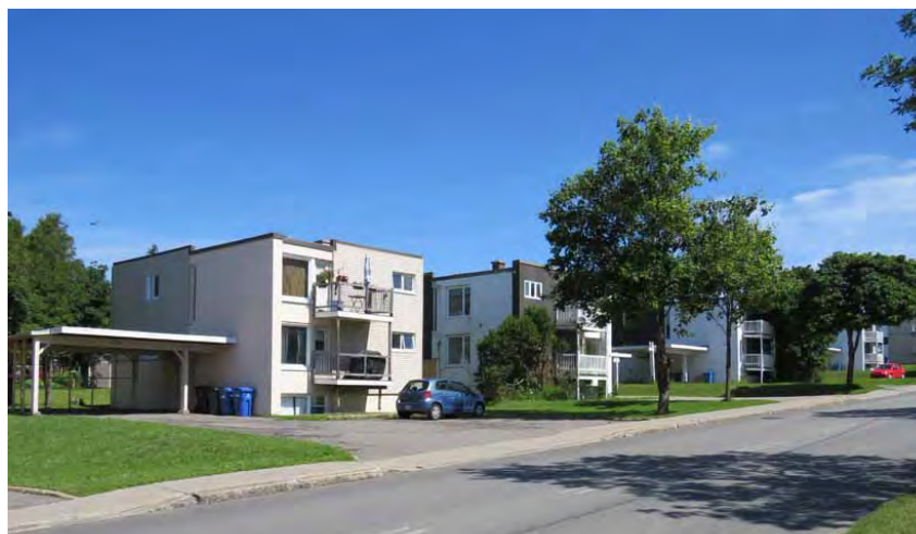
Quatre des 10 édifices résidentiels à toit plat érigés en 1964, le long du chemin des Quatre-Bourgeois, les 3124 à 3184. Ils sont tous « impactés ».
