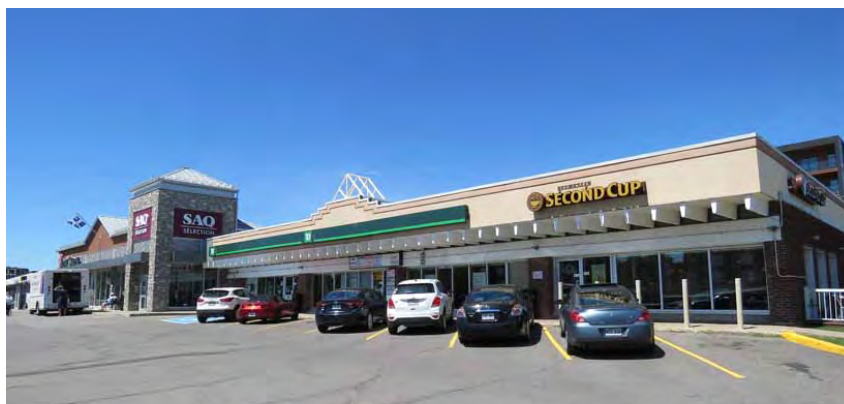
Édifices commerciaux à l'ouest de l'avenue Bégon : les 3400 (à droite) et 3440, chemin des Quatre-Bourgeois.
