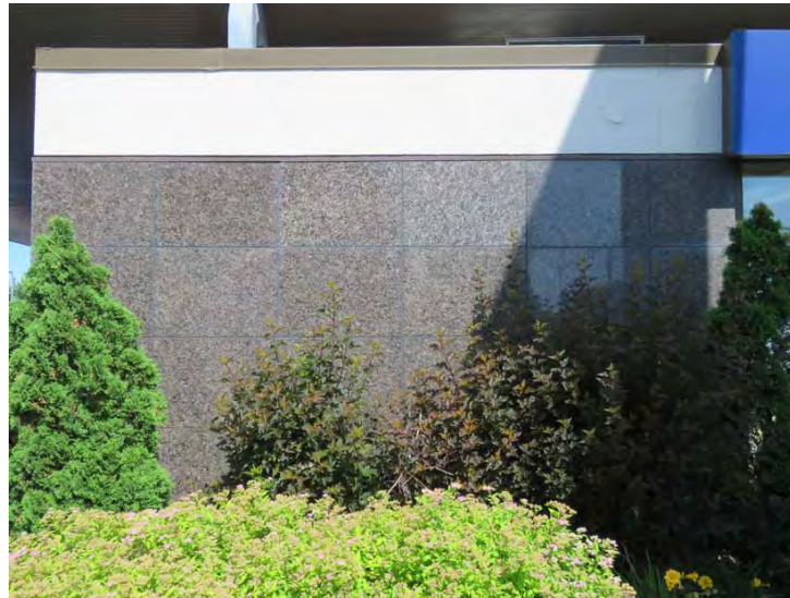
Revêtement de marbre au 2860, chemin des Quatre-Bourgeois.
