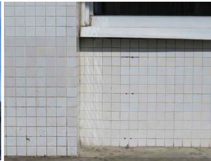
Revêtement de céramique au rez-de-chaussée du 909-919, rue Monseigneur-Grandin.
