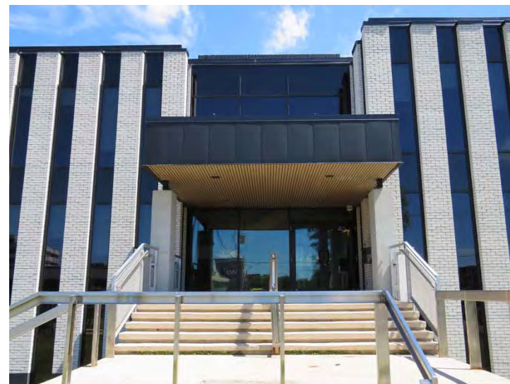
Entrée principale du 1001, avenue Bégon autour duquel est structurée l'organisation de l'édifice.
