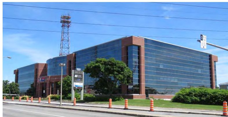
Le 3075, chemin des Quatre-Bourgeois, situé juste à côté du 3083, la seule propriété « impactée ». localisée du côté sud de l'artère.
