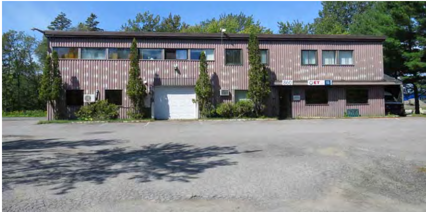
Façade avant du 860, boulevard de la Chaudière.
