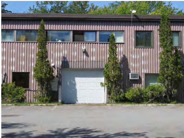
Détail du revêtement et des ouvertures : tôle profilée et ouvertures métalliques du 860, boulevard de la Chaudière.
