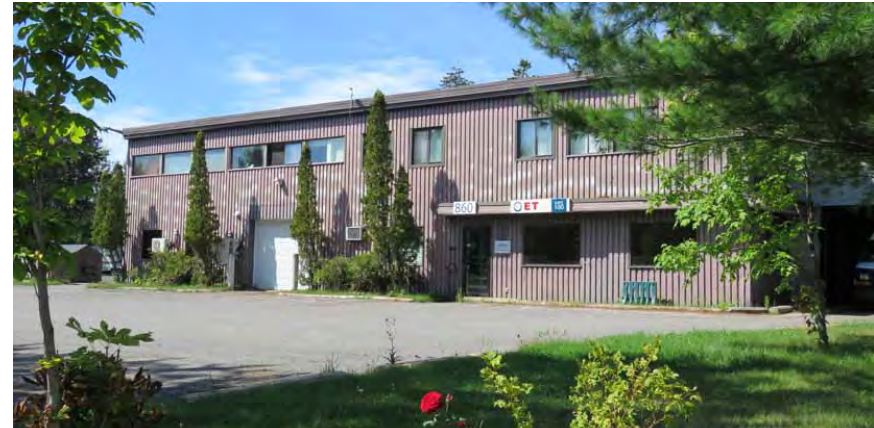
Façade avant du 860, boulevard de la Chaudière.
