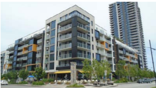
Figure 43 : Bâtiment présentant une mixité d'usages
