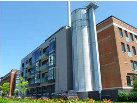
Figure 32 : Système de chauffage central à la biomasse
