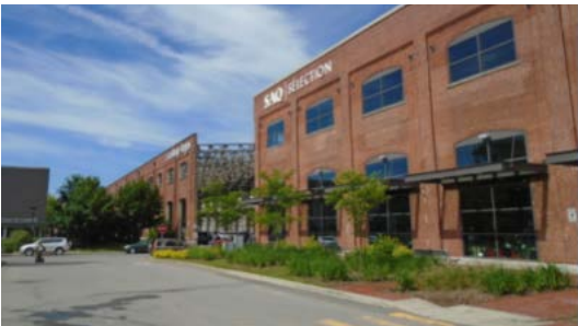
Figure 37 : Façades industrielles préservées
