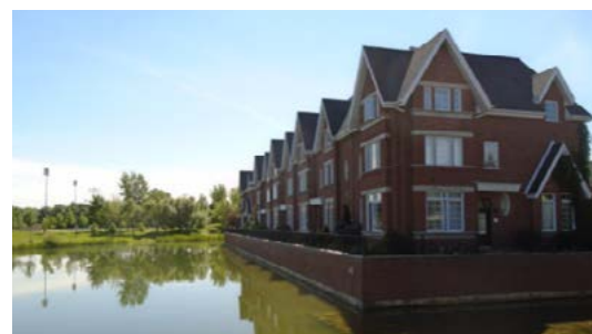
Figure 45 : Bâtiment résidentiel et bassin de rétention
