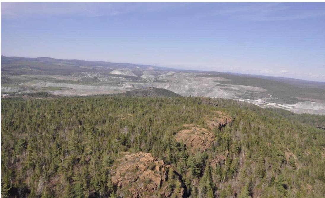
Photo QC-91 : Vue aérienne du belvédère naturel du mont Caribou en direction est
