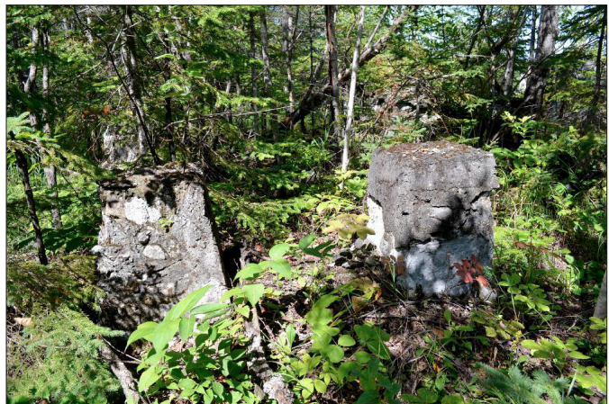
Photo 3.4 Fondations de l'atelier de traitement de la mine Windsor Répertoire du patrimoine culturel du Québec
