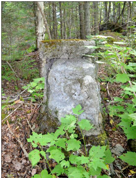
Photo 3.3 Fondations de l'atelier de traitement de la mine Windsor Répertoire du patrimoine culturel du Québec
