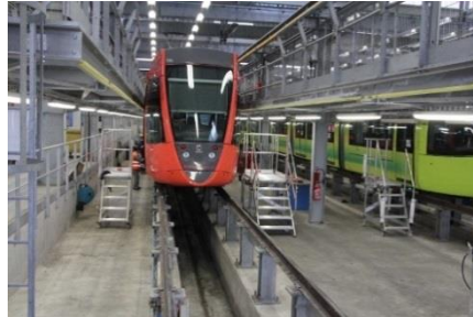
Photo 6.14 Voies sur fosse
