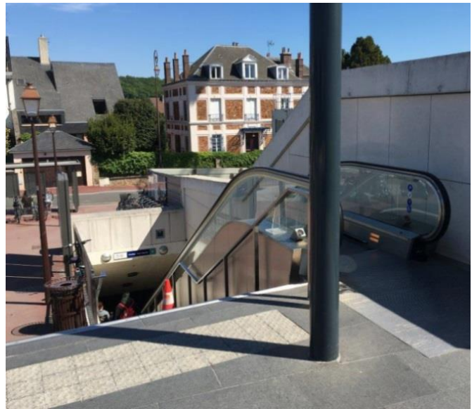
Photo 6.8 Station souterraine : entrée des escaliers
