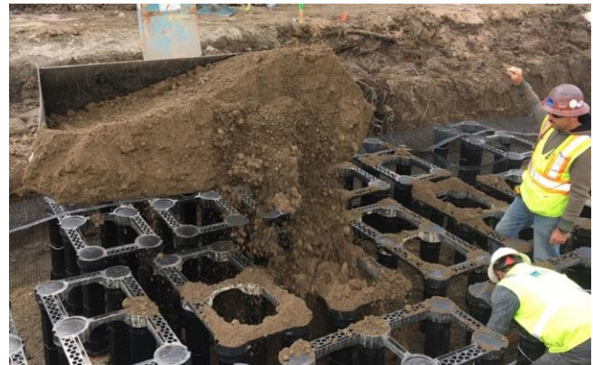
Figure 6.25 Aménagement cellulaire – Chantier de l'installation du système et le remplissage des fosses avec un sol de qualité
