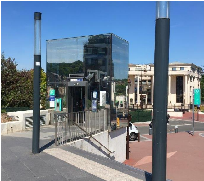
Photo 6.7 Entrée de station souterraine : édicule en surface avec ascenseurs
