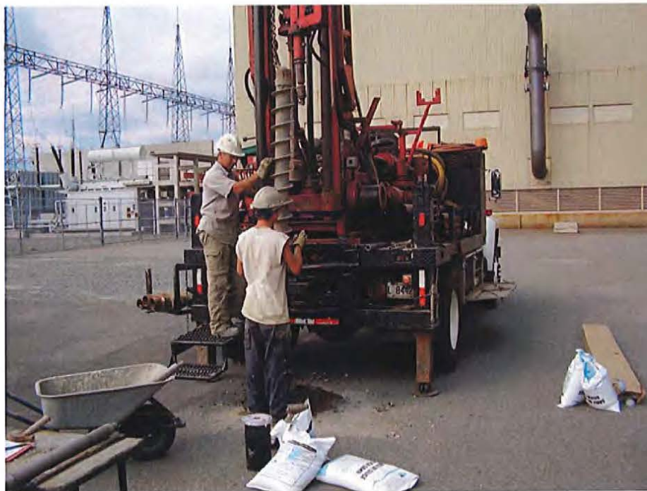
Photo 2 : Réalisation du forage PO-1 à proximité du réservoir diesel
