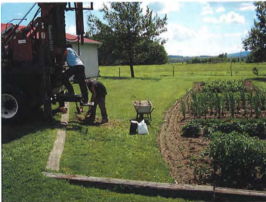
Photo 4: Installation du puits d'observation PO-6 à côté de l'atelier d'ébénisterie de Monsieur Lodge
