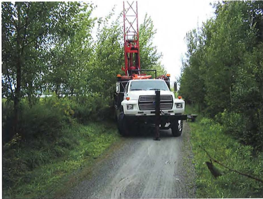
Photo 1 : Réalisation du forage PO-2 le long de la piste cyclable
