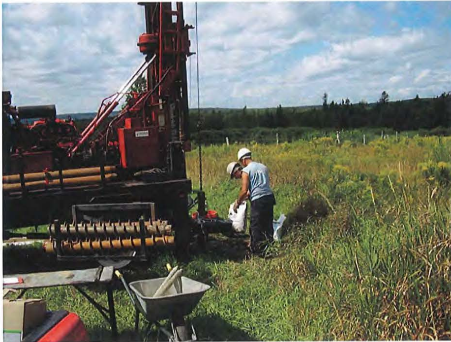
Photo 3 : Aménagement du puits d'observation PO-3 en aval des serres Savoura
