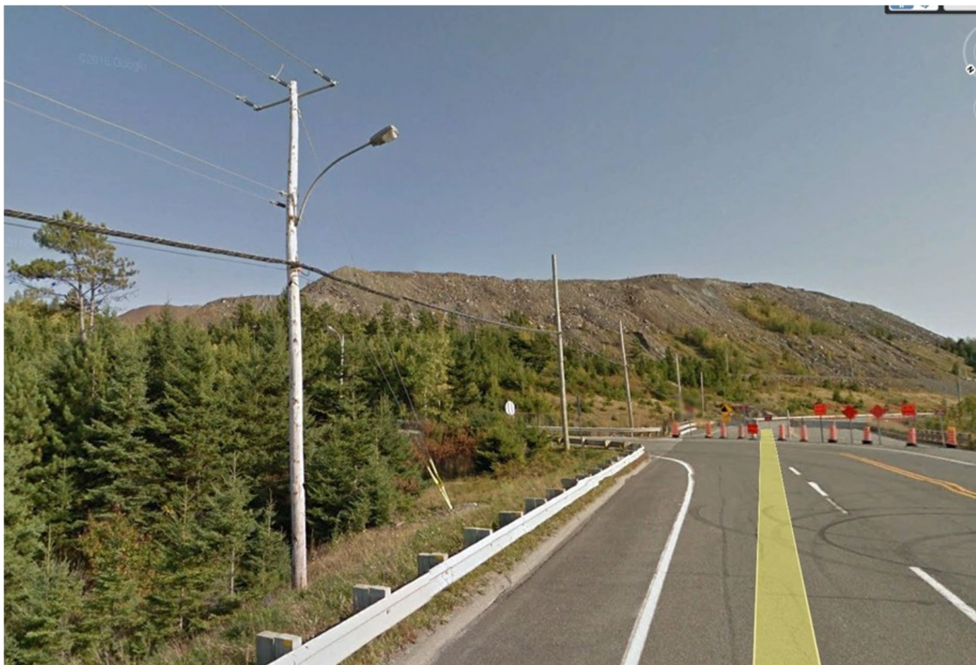
Figure 30 Halde au sud sud-est du Centre communautaire
