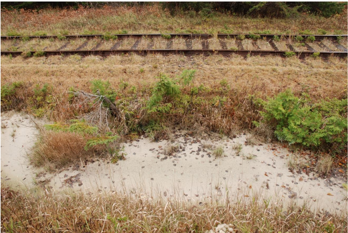
Figure 10 : résidus miniers accumulés dans un fossé près du pied de la halde
