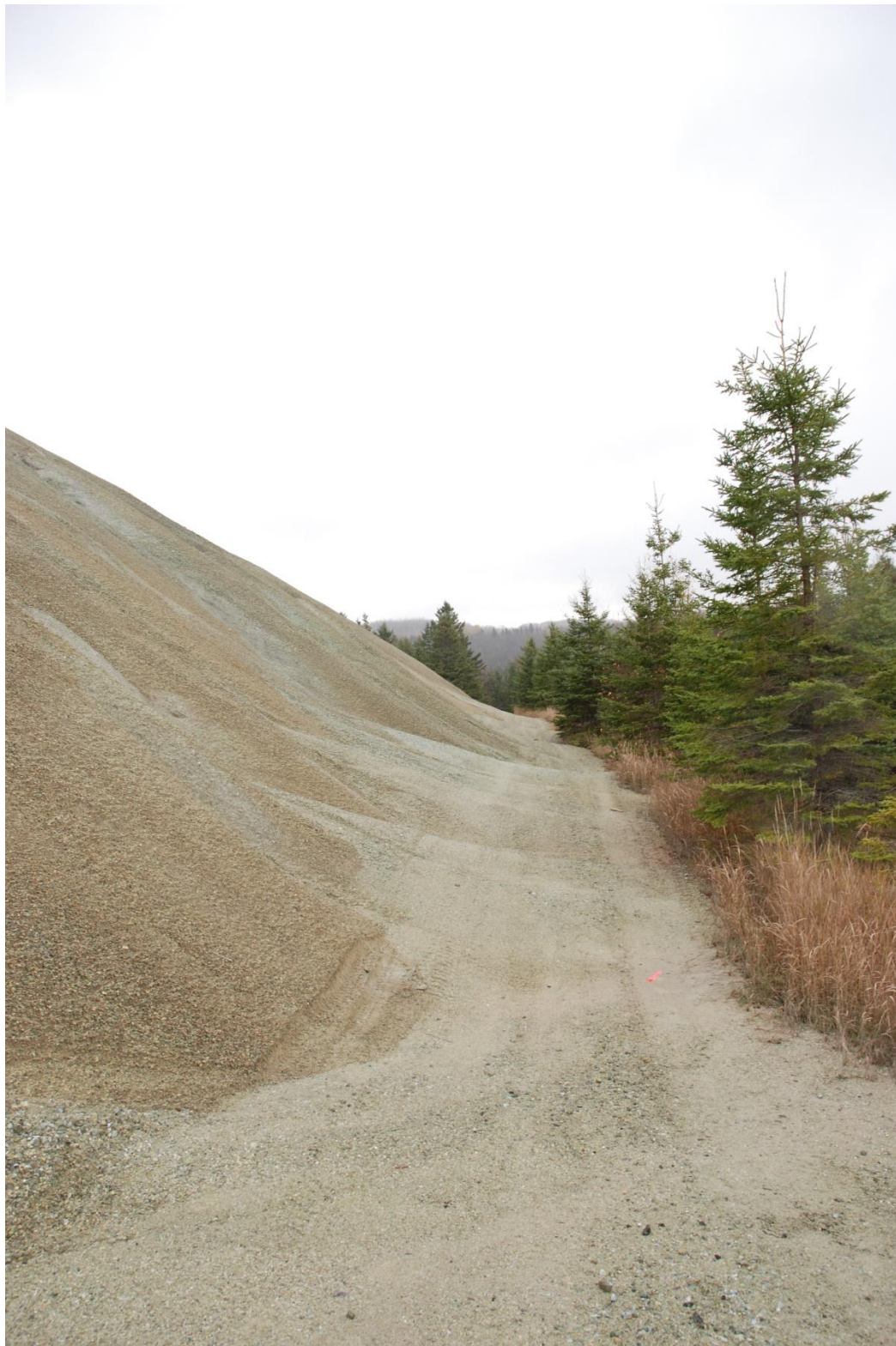
Figure 3 : débris grossiers accumulés au pied de la halde de résidus, mine Boston
