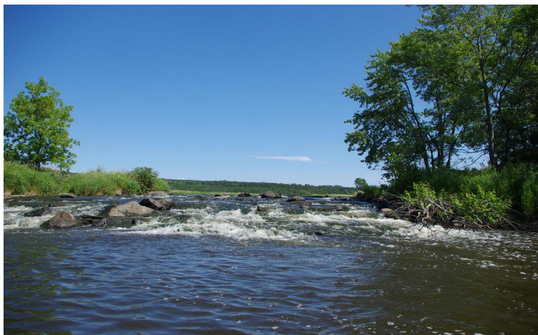
Photo 6 Vue de l'aval sur le déversoir.
