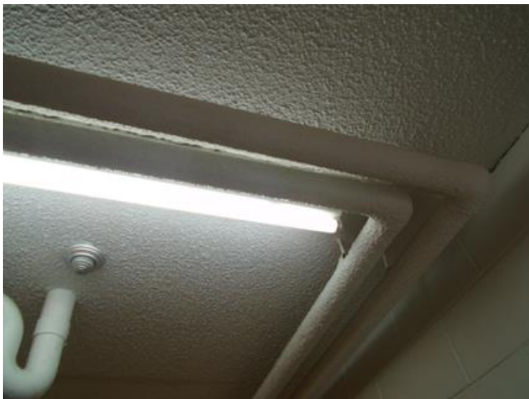
Figure 2 Le flocage doit être inscrit au registre de chaque habitation. Il s'agit d'une peinture contenant de l'amiante. Pour en avoir l'assurance, une analyse est nécessaire.
