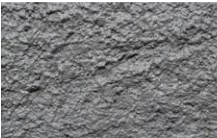
Figure 2 Le flocage doit être inscrit au registre de chaque habitation. Il s'agit d'une peinture contenant de l'amiante. Pour en avoir l'assurance, une analyse est nécessaire.
