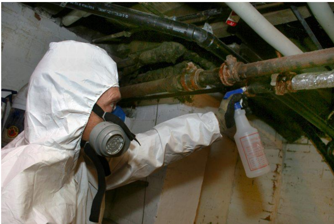
15 Les tuyaux entourés de calorifuges
