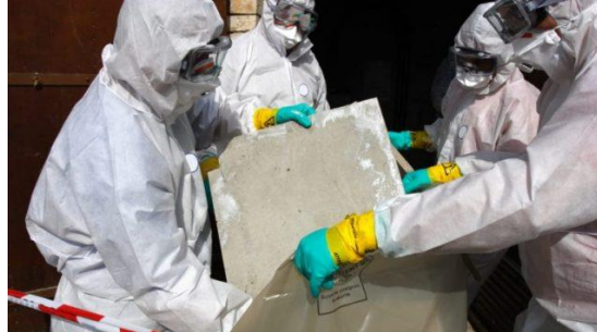
Figure 3 : Gestion de matériaux contenant de l'amiante. Photo de ISTOCK.
