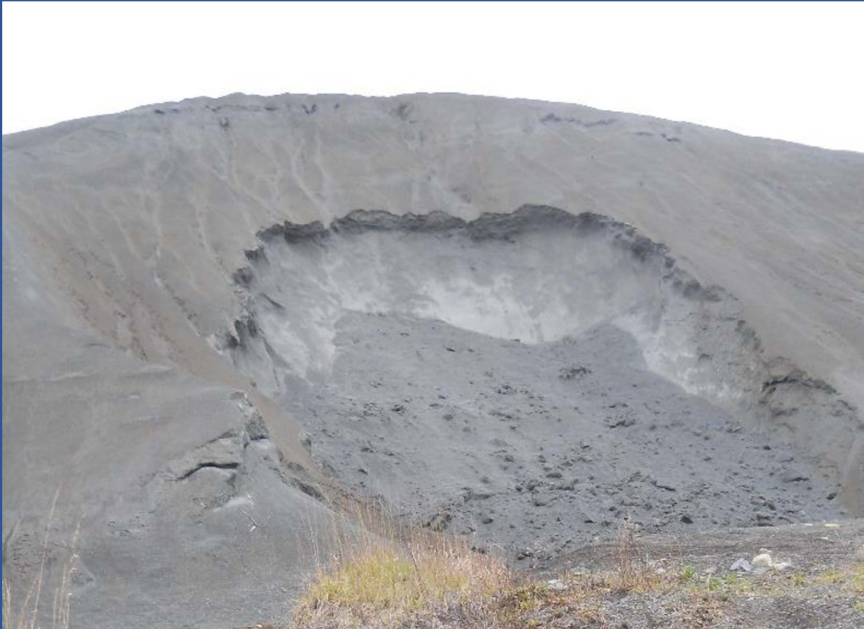
Décrochement sur une halde de RMA du secteur de Thetford Mines (GROBEC, 7 nov 2014)
