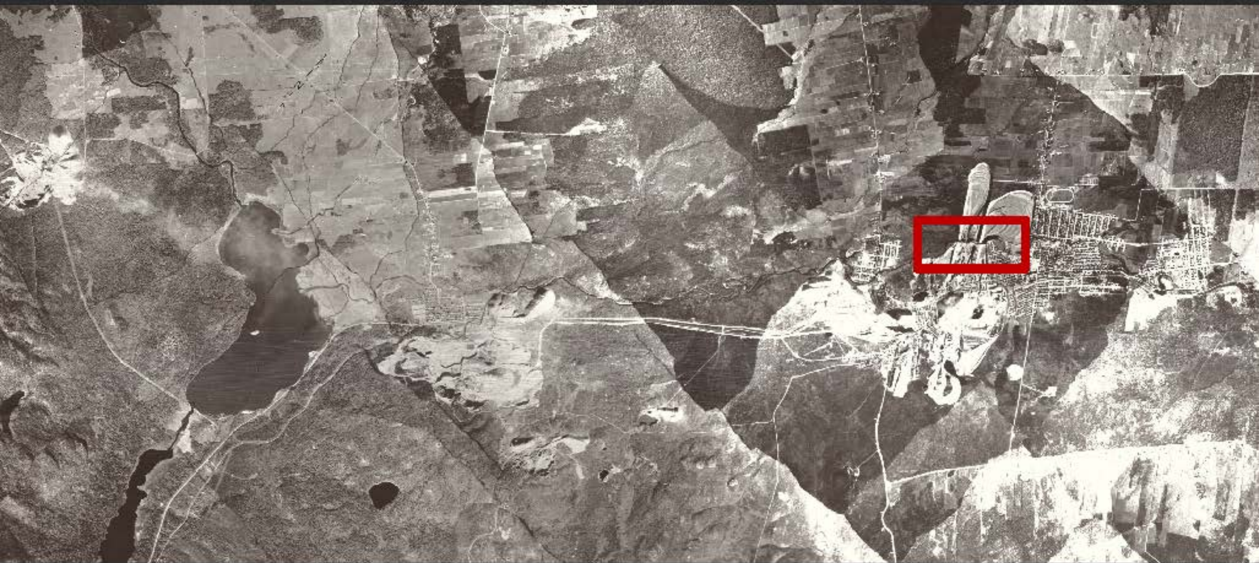
Réfection de la traverse de la mine Bell, 1976
