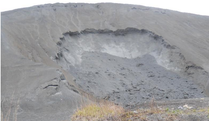
Décrochement sur une halde de RMA du secteur de Thetford Mines (GROBEC, 7 nov 2014)
