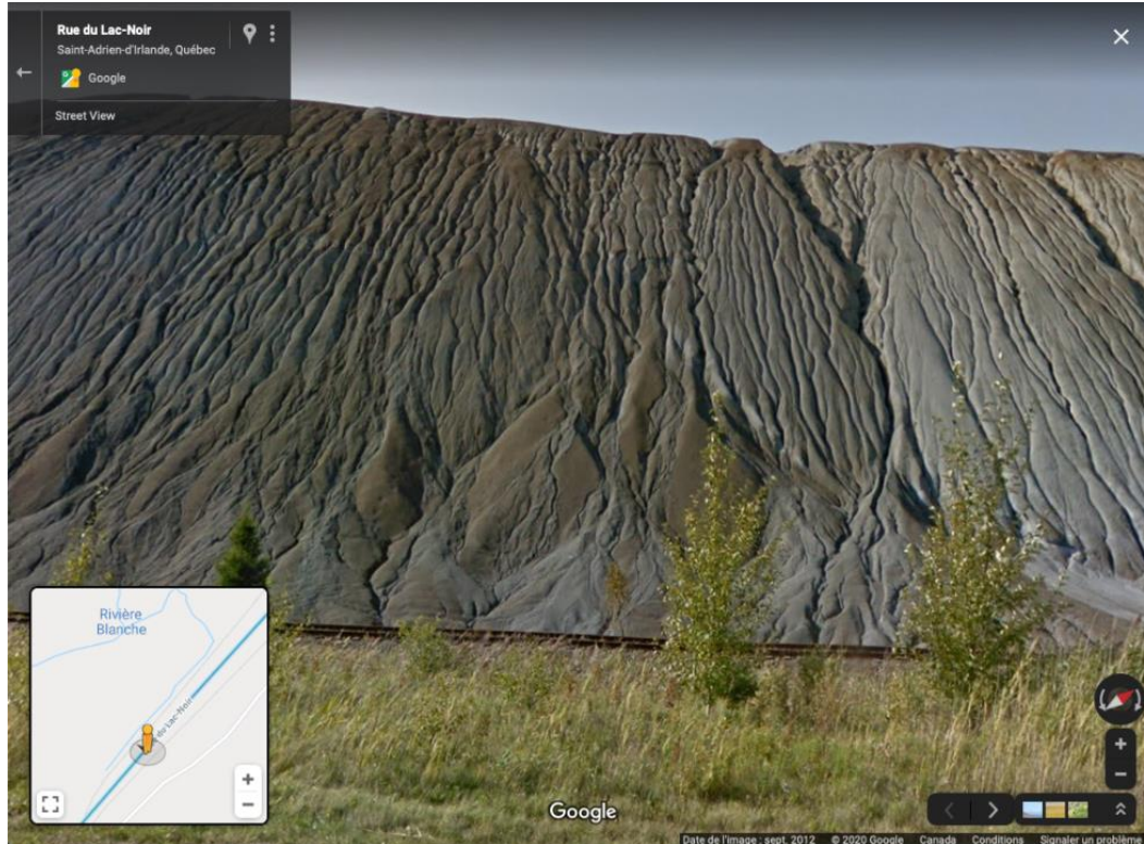
Exemple d'érosion hydrique sur le versant d'une halde minière (Google Street view)
