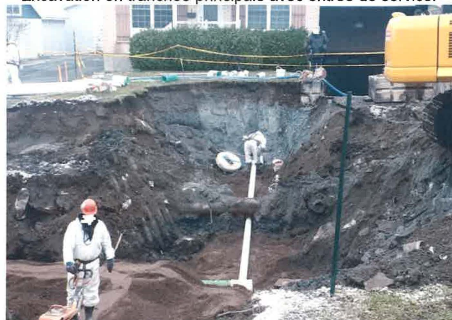
Excavation en tranchée principale avec entrée de service.
