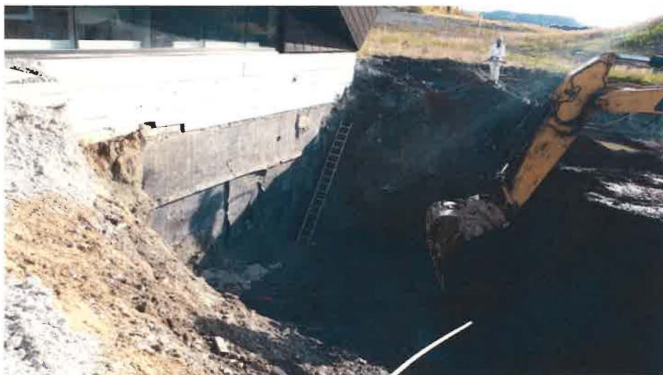
Excavation de la galerie.
