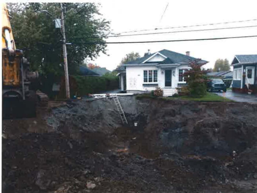
Excavation en tranchée principale avec entrée de service
