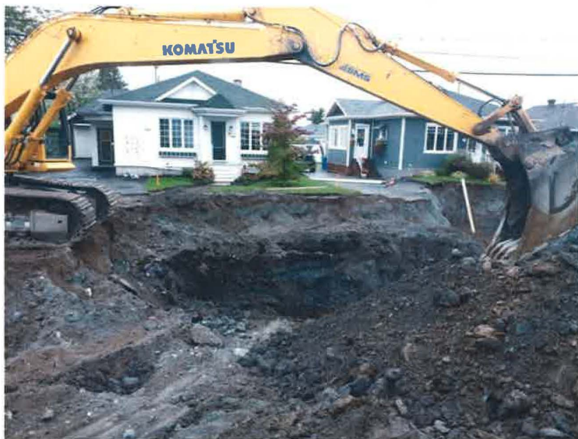
Excavation en tranchée principale avec entrée de service
