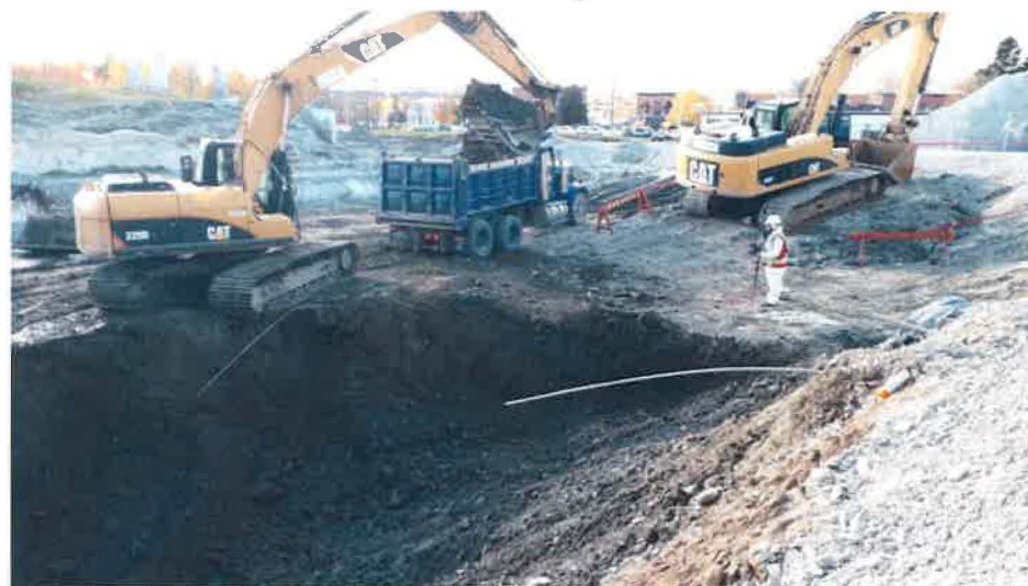
Excavation de la galerie.
