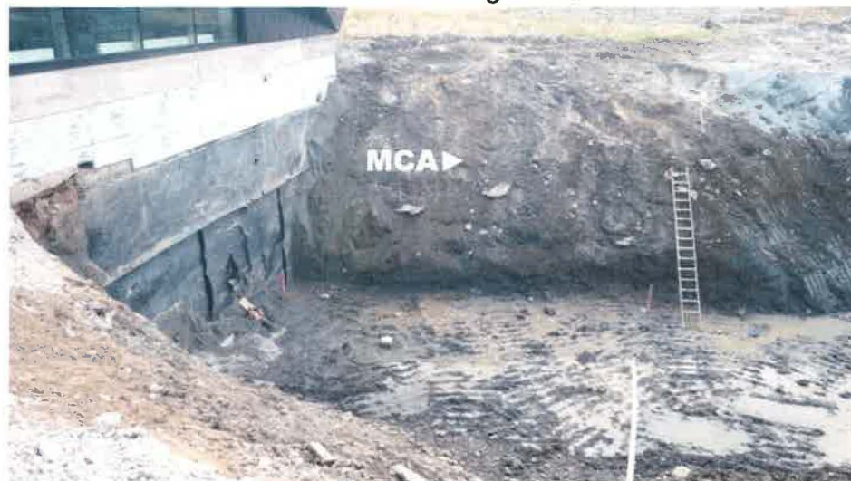
Excavation de la galerie.
