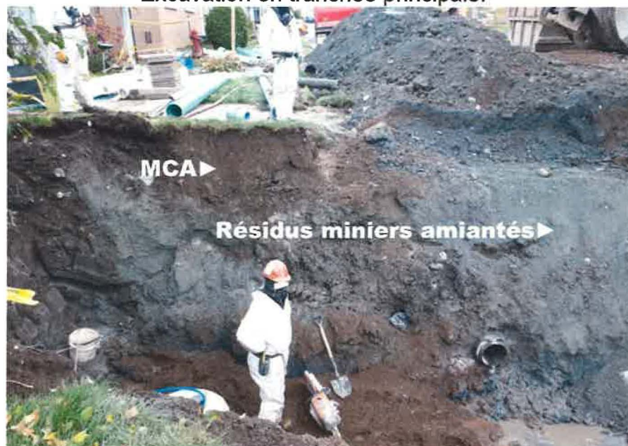
Excavation en tranchée principale.
