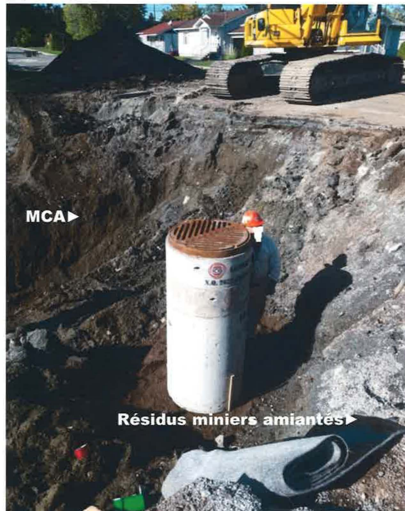
Excavation en tranchée principale
