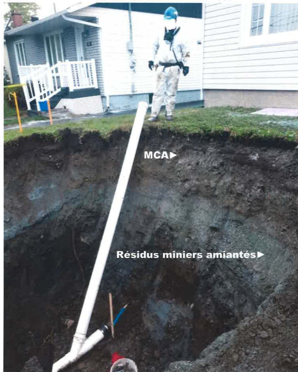
Excavation entrée de service.
