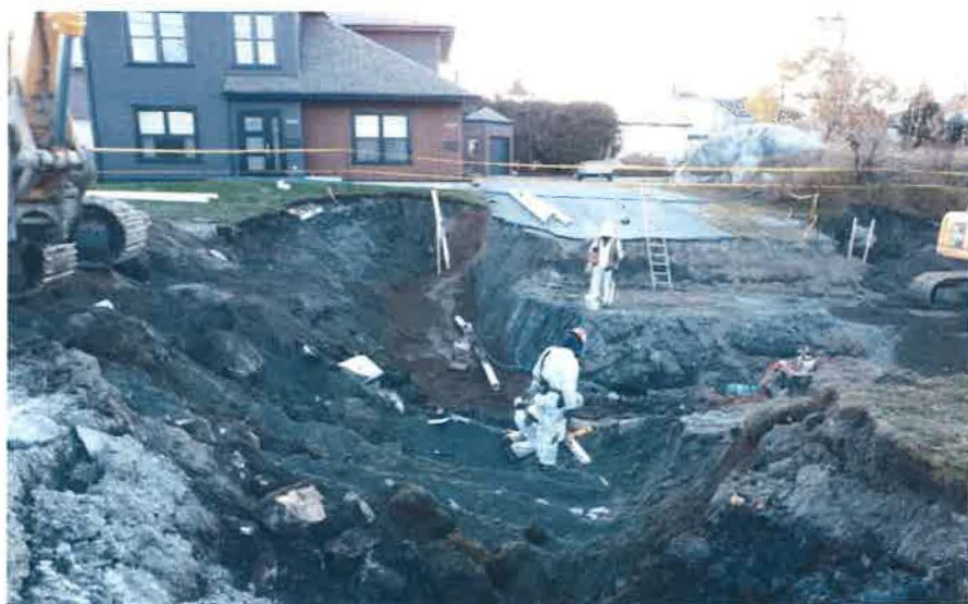
Excavation en tranchée principale.
