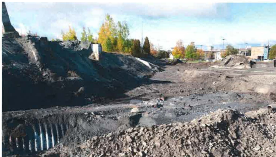
Excavation de la galerie.
