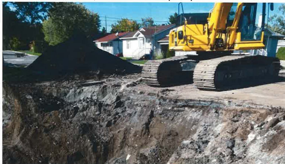
Excavation en tranchée principale.
