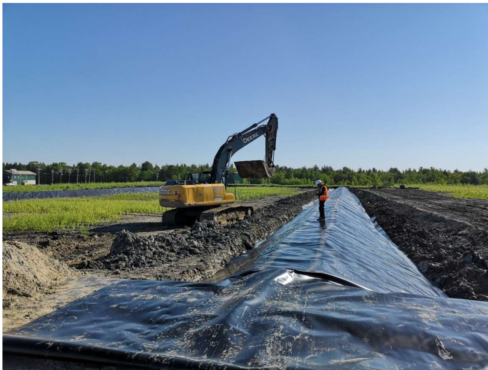
Photo 9. Construction des bermes de confinement par Waste Management – juin 2019
