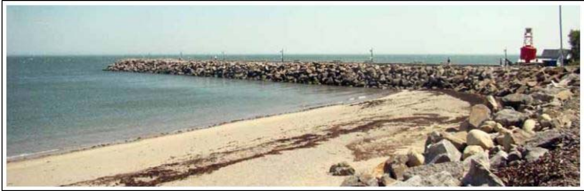
Figure 37 Jetée des Capelans à Saint-Irénée
